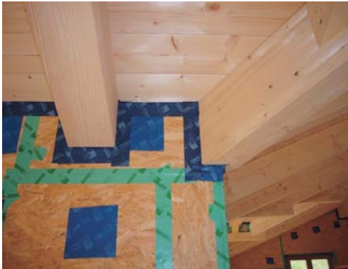
Fotografías 17 y 18. (Izq.) Sellado de estructura de madera. (Drcha.) Sellado de unión de la ventana con la estructura de madera. Fuente: Wolfgang Berger, www.arkimo.es .
