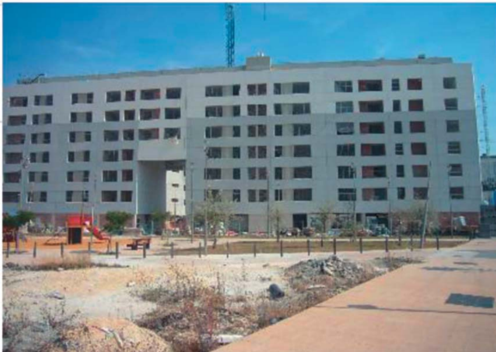
Fotografía 1. Edificio en fase de construcción.
