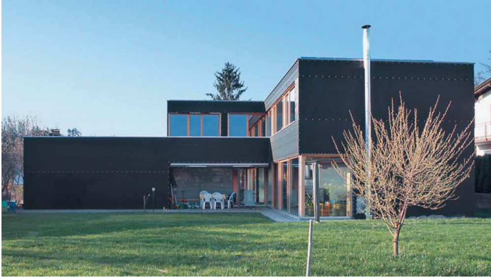
Fotografía 12. Vivienda en Vorarlberg (Austria). Fuente: iPHA.
