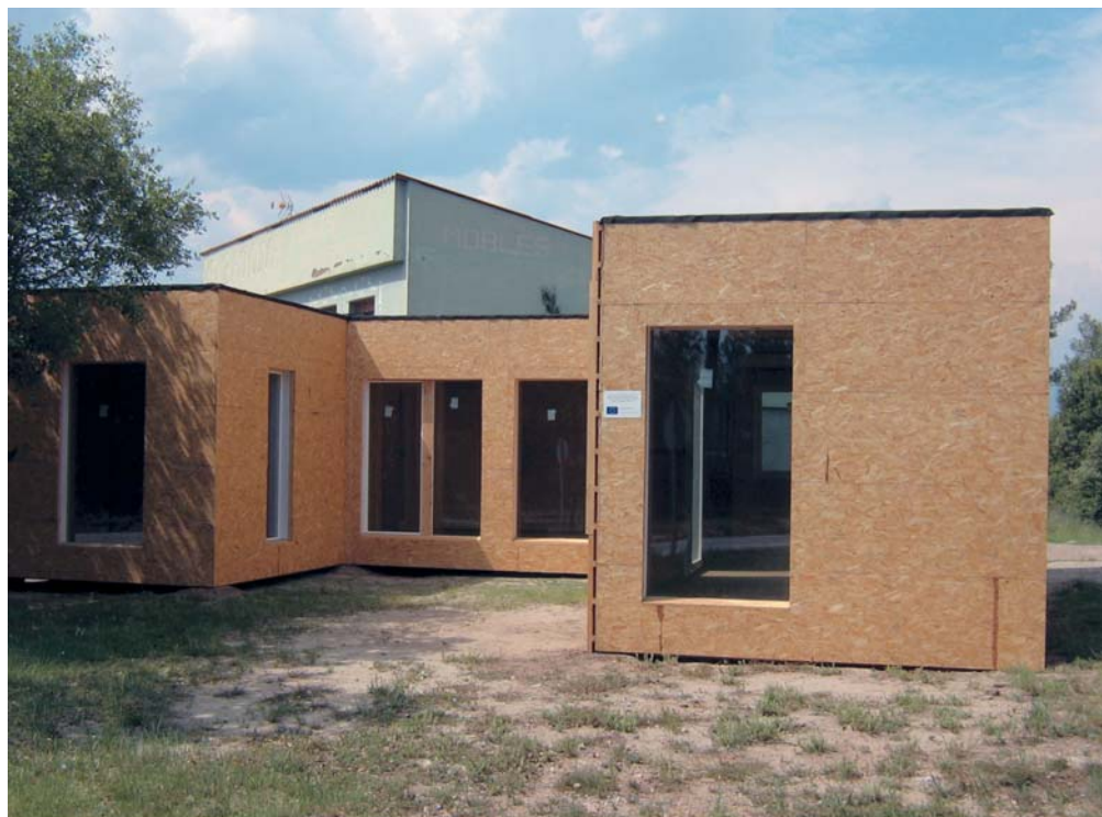
Fotografía 21. Casa EcoOci, estado actual. Fuente: EcoOci.
