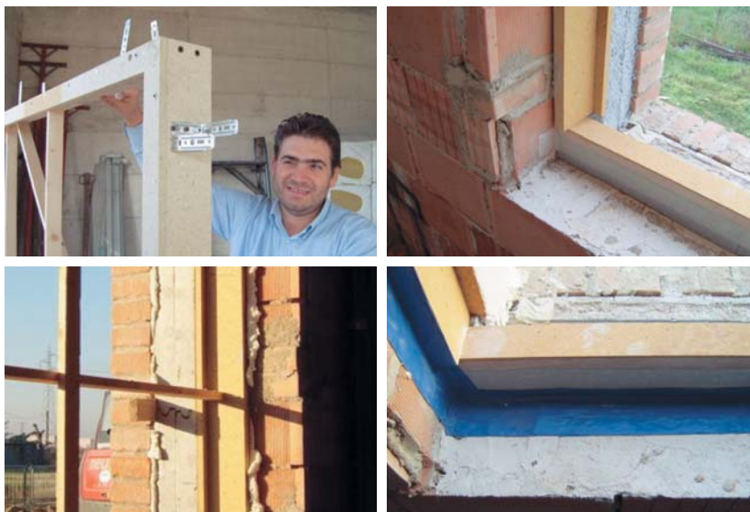
Fotografía 8. Montaje premarco de la carpintería. Fuente: TBZ.
