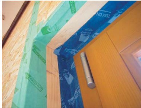
Fotografías 17 y 18. (Izq.) Sellado de estructura de madera. (Drcha.) Sellado de unión de la ventana con la estructura de madera. Fuente: Wolfgang Berger, www.arkimo.es .
