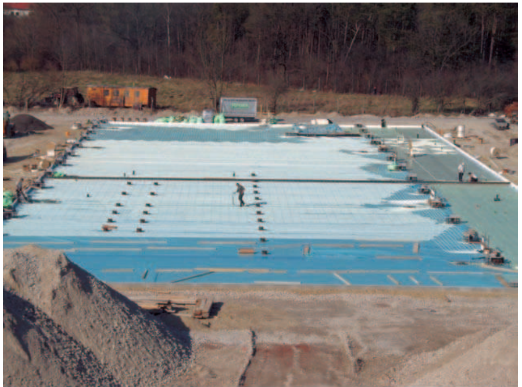
Foto 1. Suelo radiante en construcción (Foto: Citrin Solar).
