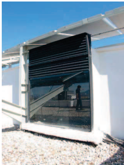
Foto 2. Captador de una de las chimeneas solares.
