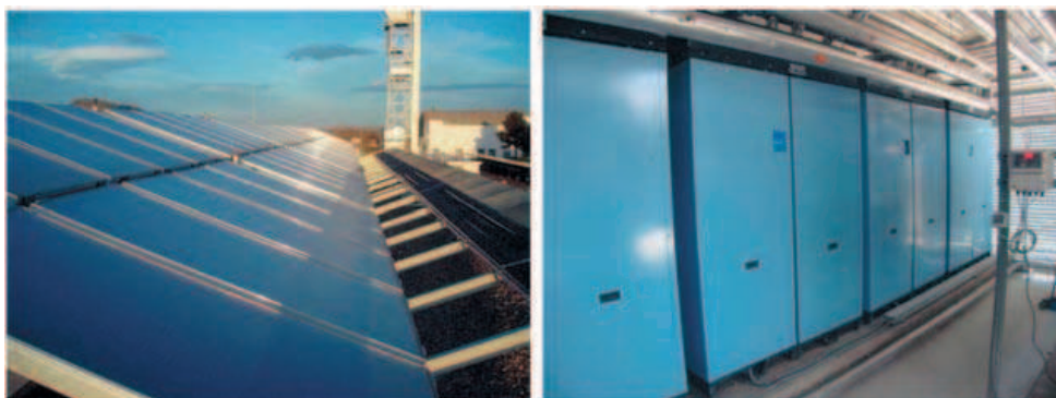
Fotos 3 y 4. Campo de captación solar (izq.) y bombas de calor por absorción (dcha.).
