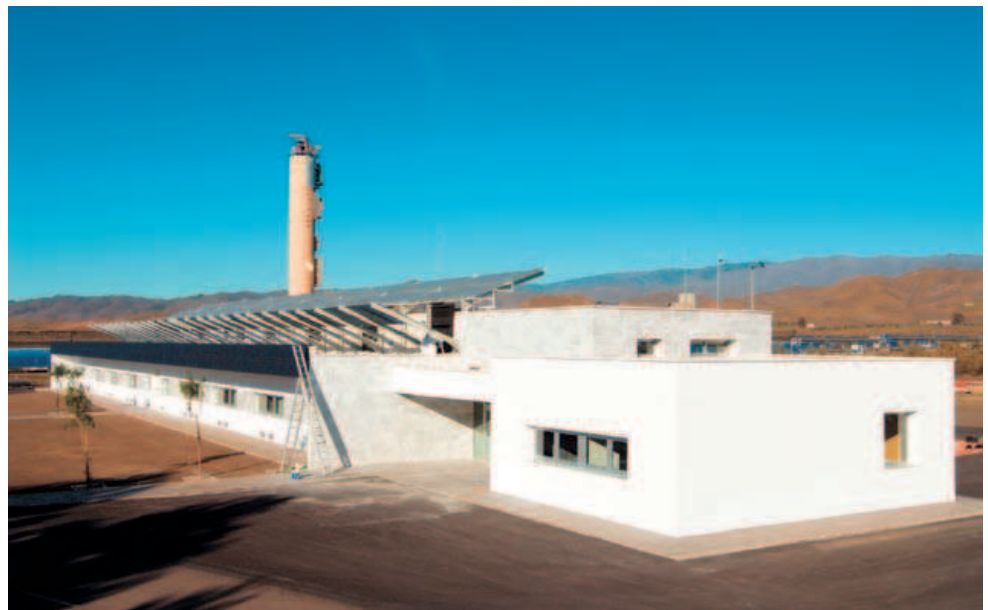
Foto 1. Edificio ubicado en la PSA.
