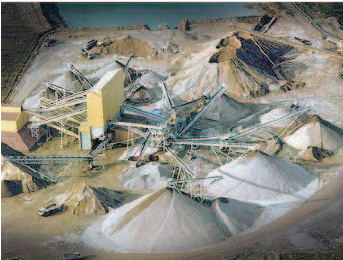
Foto 6.12. Panorámica de una planta de tratamiento en la que la mayoría de los acopios se ubican al aire libre (Fuente: Metso Minerals).
