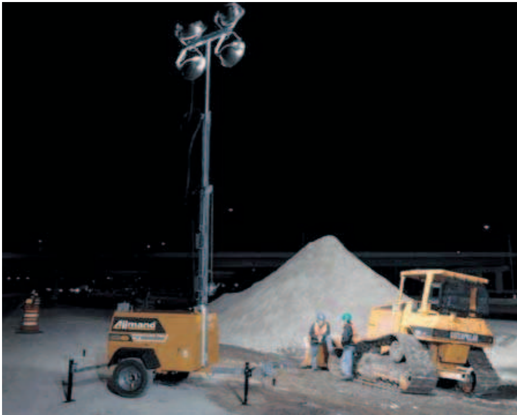
Foto 6.14. Torre móvil de iluminación formada por cuatro lámparas de halogenuro metálico (Fuente: Allman).
