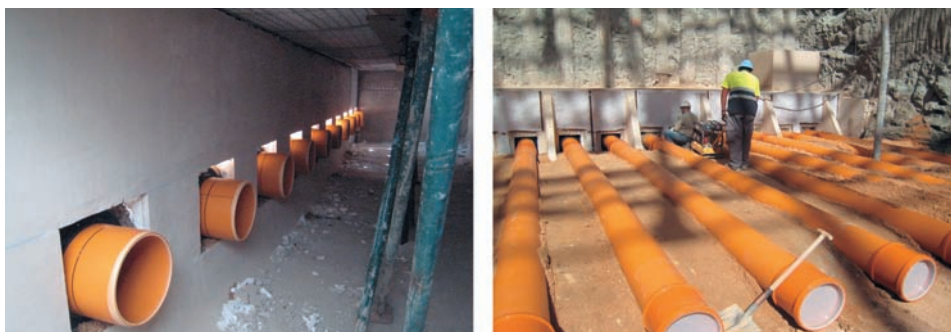
Figura 10. Colector de un intercambiador geotérmico tierra/aire con una capacidad de 20.000m 3 /hora, en la rehabilitación del cuartel de Daoiz y Velarde para Teatro Infantil del Ayuntamiento de Madrid. Proyecto energético y ejecución de Eneres.
