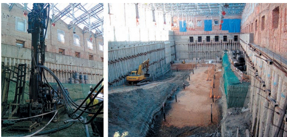
Figura 16. Ejecución de un intercambiador geotérmico agua/agua con 33 colectores verticales para calefacción y refrigeración y un intercambiador tierra/aire para el pretratamiento del aire de renovación, ambos integrados, en la rehabilitación del cuartel de Daoiz y Velarde para Teatro Infantil del Ayuntamiento de Madrid. Proyecto energético y ejecución de Eneres.
