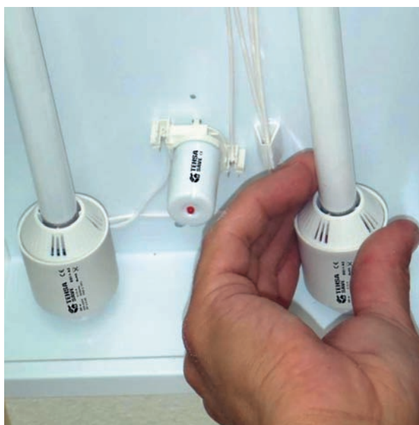
Foto 4. Tubos fluorescentes T5 con adaptadores TEHSAsave electrónicos.
