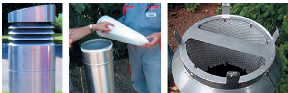
Figura 7. Detalles de la toma de aire de un intercambiador geotérmico tierra/aire.
