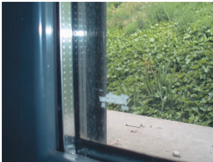
Foto 3.7. Vidrios con rotura de puente térmico en la facultad de Educación de la UCM.
