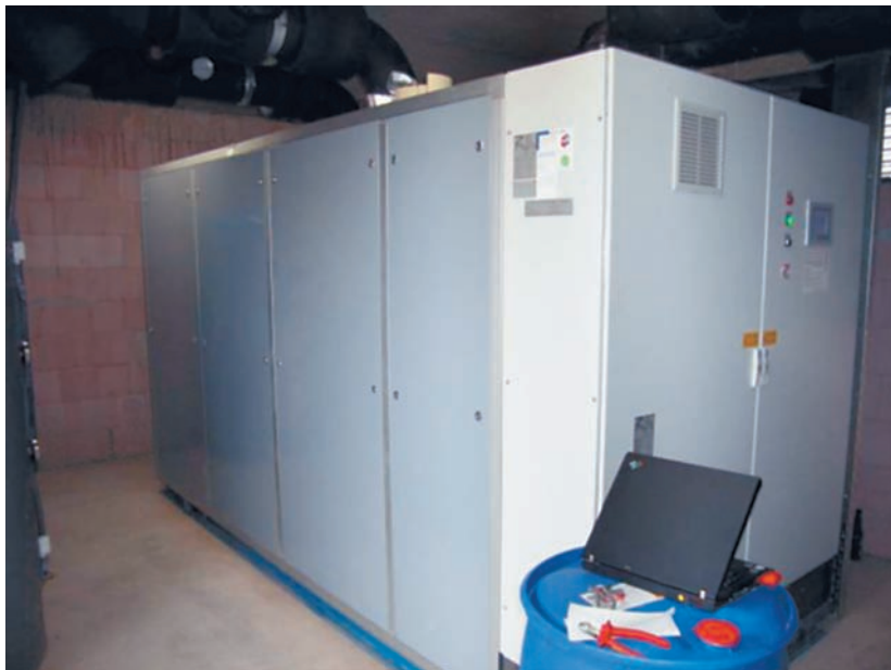
Foto A1.4. Bomba de calor geotérmica para altas potencias (unidad central de energía Geozen@ profi).
