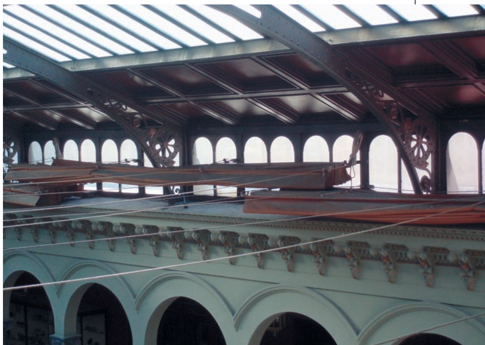
Foto A2.1. Sistema de protección solar instalado en la ETSI Minas de la UPM.
