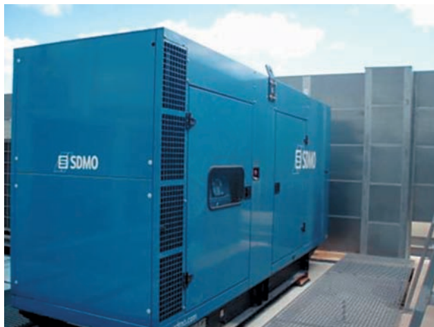
Foto A1.6. Ejemplo de grupo electrógeno montado en cubierta.
