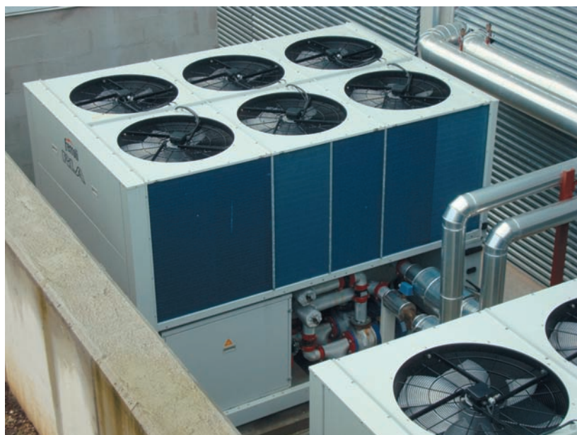
Foto A1.6. Enfriadora para grandes instalaciones tipo RLA. (Fuente: Ferrolli).
