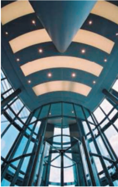
Foto A2.5. Techos fríos/calientes en edificio terciario. (Fuente: Zent Frenger).
