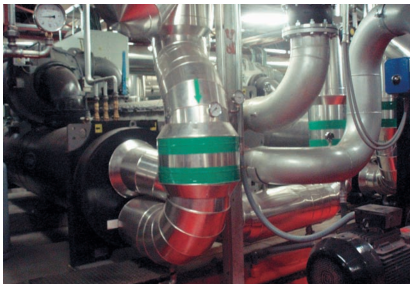
Foto 3.6. Detalle de sala técnica con equipos generadores de frío en el Centro Comercial La Vaguada.
