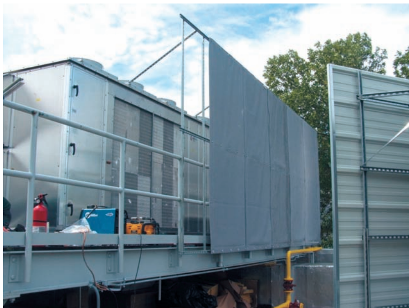
Foto 4.1. Colocación de pantallas para la atenuación de unidades exteriores en instalaciones de climatización
