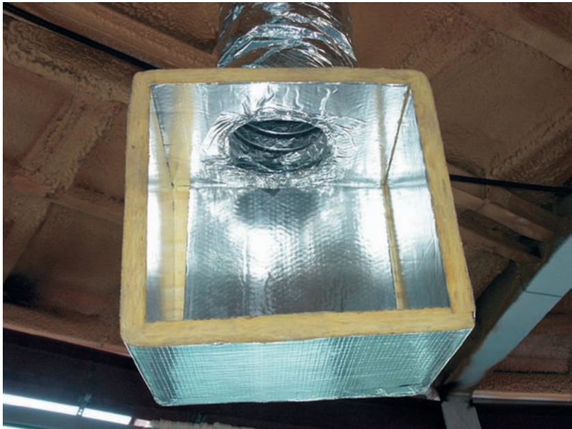
Foto 5.1. Conducto fonoabsorbente.
