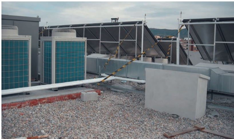
Foto 3.3. Apantallamiento de los equipos exteriores por captadores solares.
