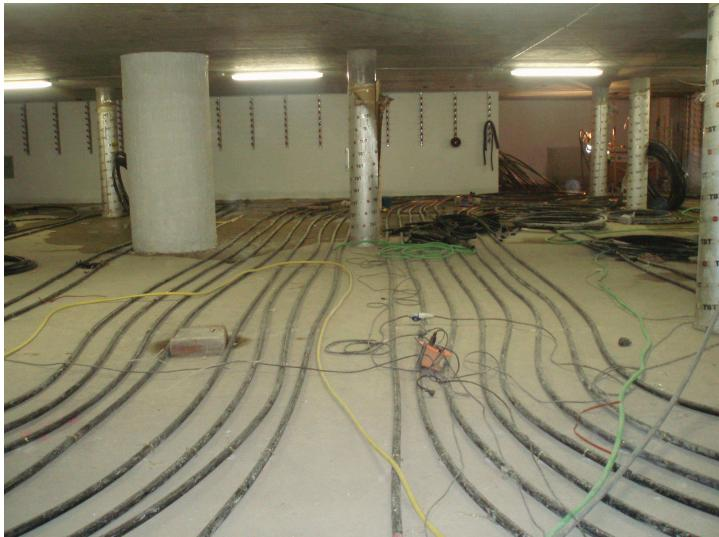
Este proyecto, en el que han participado Metro de Madrid, Termoterra, IFTec Geoenergía y FCC, ha consistido en la implantación de una instalación de intercambio energético basado en bombas de calor geotérmico para la climatización de las futuras oficinas subterráneas y los dos andenes de la estación de Pacífico de Metro de Madrid.
