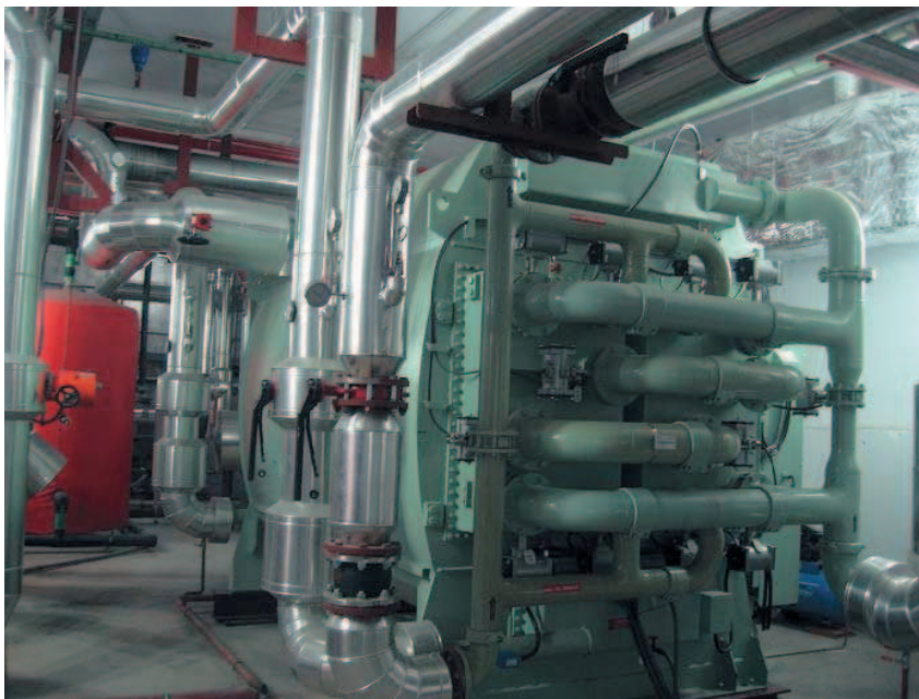
Foto 3. Vista de una máquina de absorción en un polideportivo de la Comunidad de Madrid.
