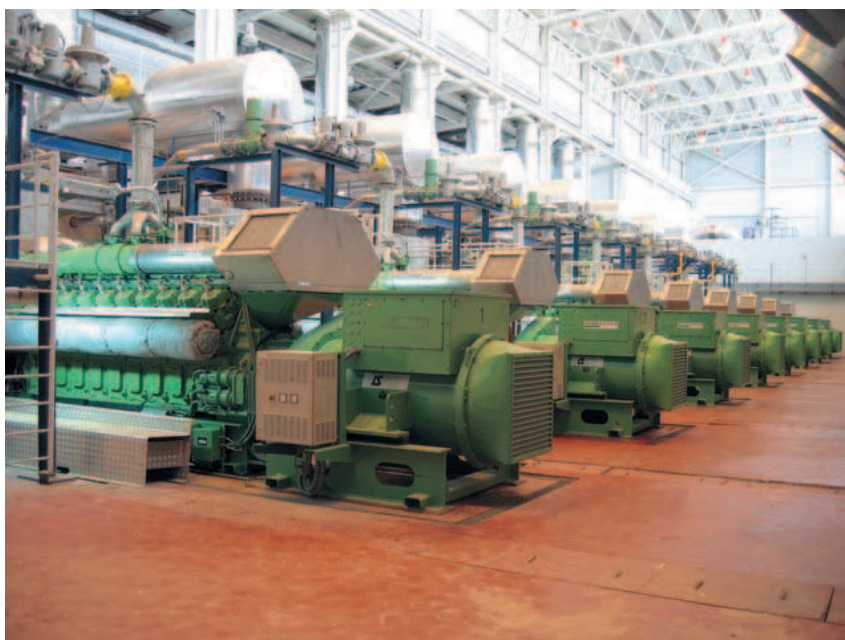
Foto 3. Vista lateral de los ocho motores a gas (cuatro unidades generadoras y cuatro de cogeneración). Fuente: GE Jenbacher.
