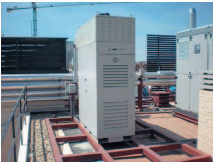
Foto 1. Microturbina y calderas en cubierta del edificio. Fuente: AESA.
