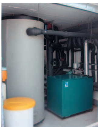
Figura 1. Izqda.: Vista del interior de la sala de calderas del edificio. Dcha.: Detalle del módulo de microcogeneración Senertec DACHS.
