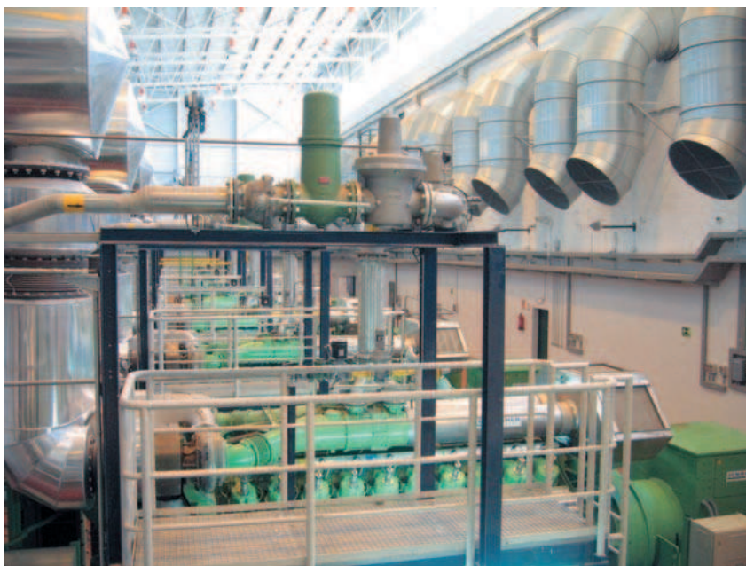
Foto 4. Vista superior de los motores a gas. Fuente: GE Jenbacher.
