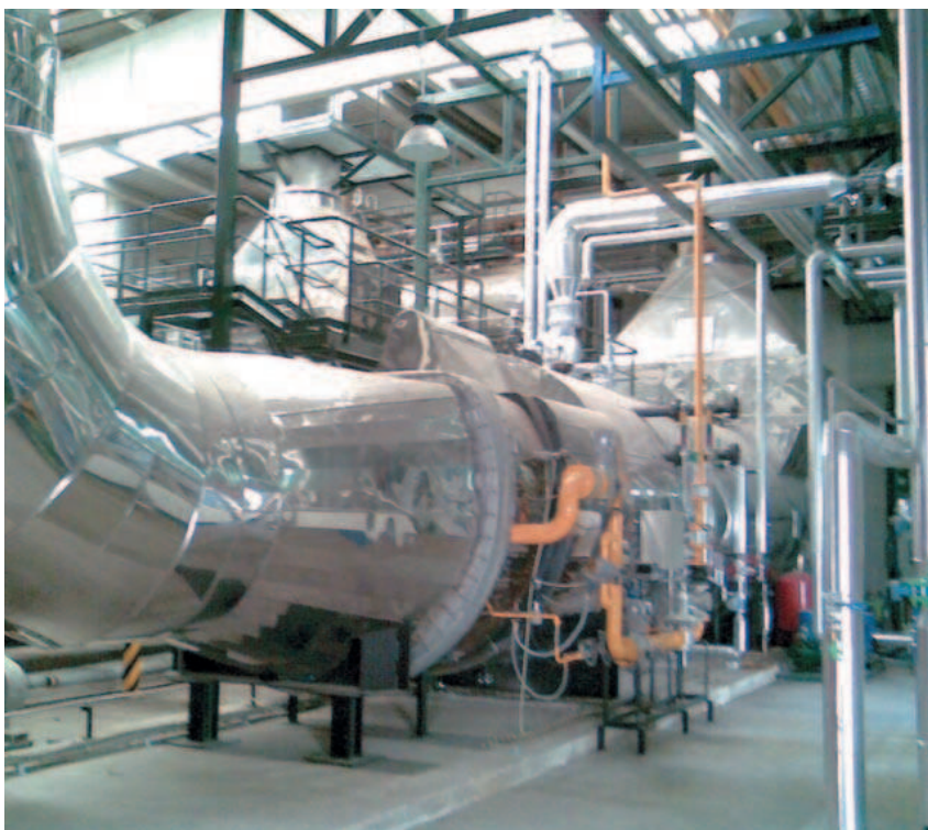
Foto 4. Detalle de la caldera de recuperación de calor.
