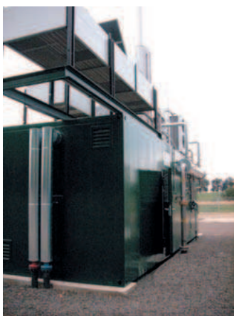
Foto 2. Contenedor amortiguador de ruido.
