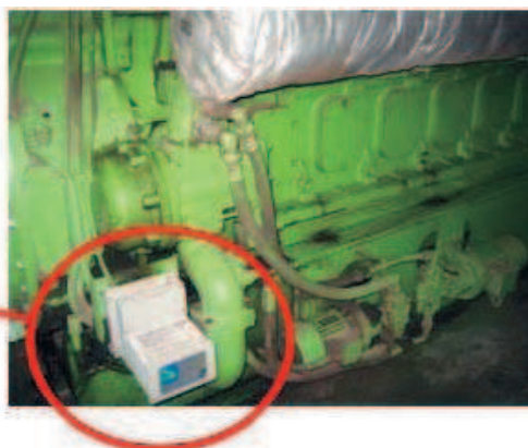
Foto 2. Sistema antidetonación en un motor GE-Jenbacher 620. Fuente: Archivo Renovetec.
