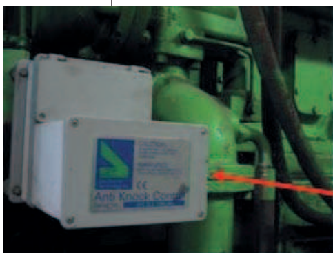
Foto 2. Sistema antidetonación en un motor GE-Jenbacher 620. Fuente: Archivo Renovetec.
