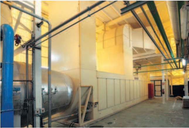
Foto 1. Turbogenerador a gas Titan 130 instalado en Enercrisa.
