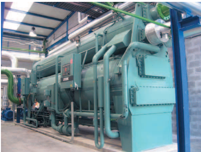
Foto 8. Unidad de absorción de Br Li de 1,2 MW funcionando con agua sobrecalentada en una planta láctea.
