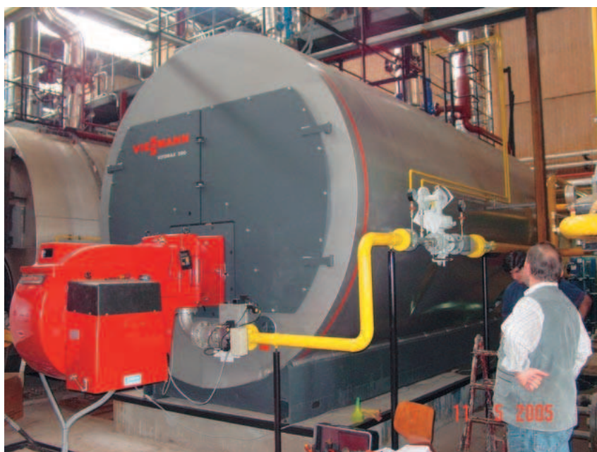
Foto 4. Caldera a gas natural de 6,5 MW.
