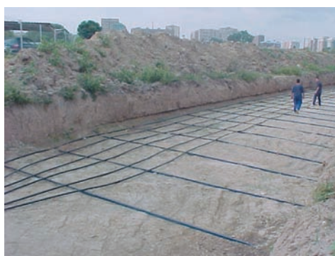
Figura 8. Intercambiador de calor horizontal enterrado. (Fuente: PROFIT).
