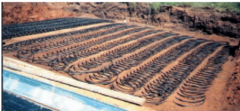
Figura 10. Intercambiador de calor "slinky". (Fuente: ELK 2004. Cortesía de EVE).
