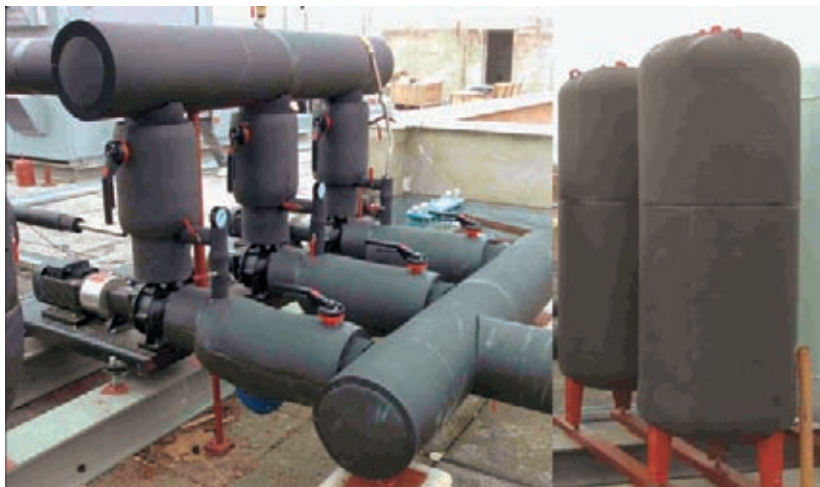
Figura 8. Planchas de aislamiento en tuberías y tanques.
