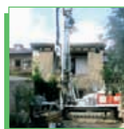
8 Madrid Perforaciones para Sondas Geotérmicas
