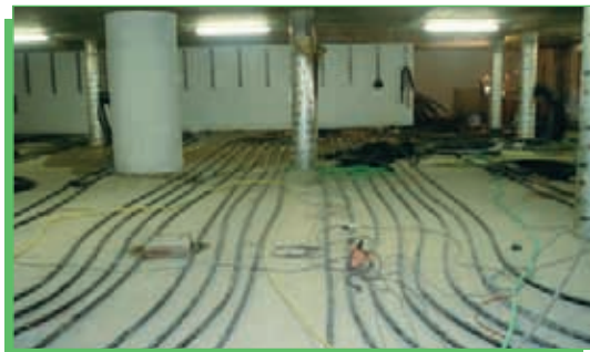
Sistema de bombas de calor geotérmico para la estación de Pacífico de Metro de Madrid
