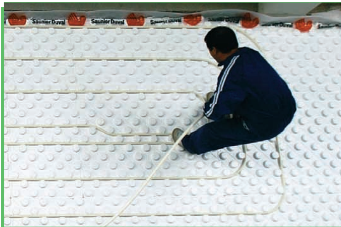
Instalación de suelo radiante (calefacción y refrigeración).
