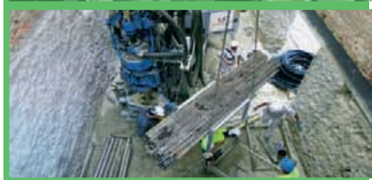
Ejecución del intercambiador geotérmico en el edificio protegido en rehabilitación
