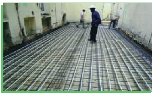
Construcción de losas termoactivas
