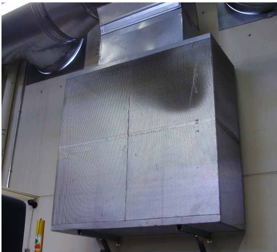
Foto 3. Plenum para difusión del aire por desplazamiento.
