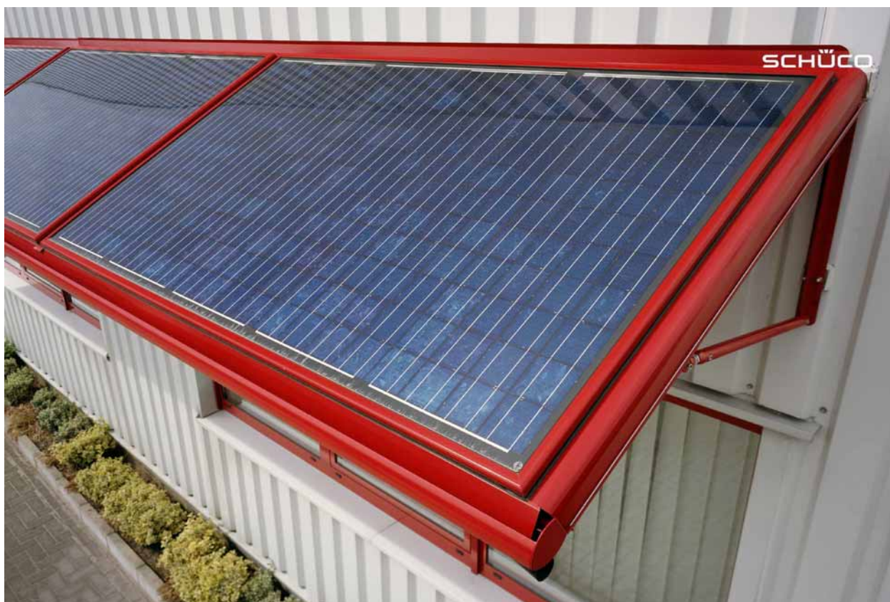
Foto 2. Solución para módulo estándar instalado en voladizo.
