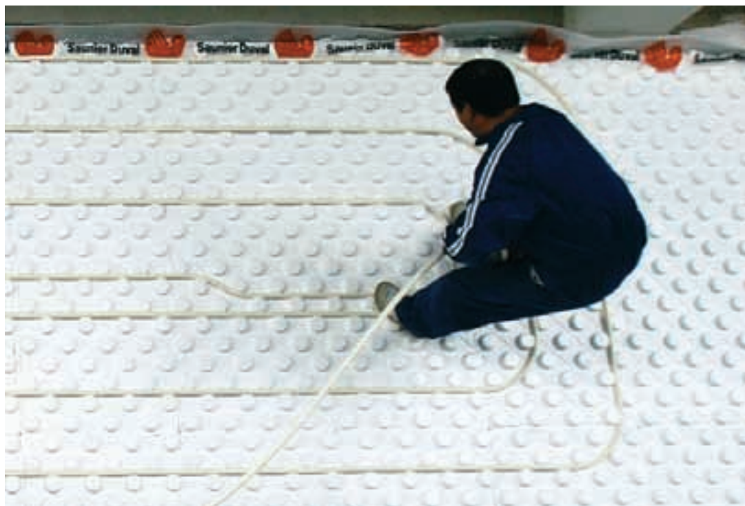
Instalación de suelo radiante (calefacción y refrigeración).
