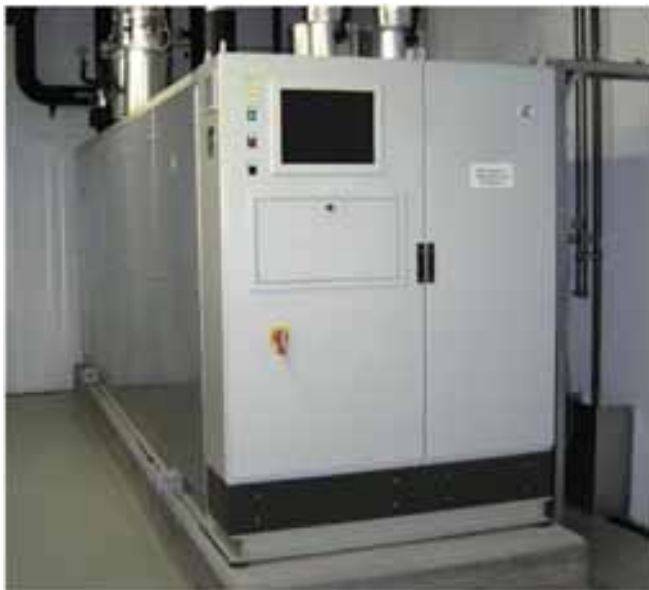
Foto A1.5. Bomba de calor geotérmica. Unidad central de energía geotérmica Geozent® profi (Fuente: Zent-Frenger).
