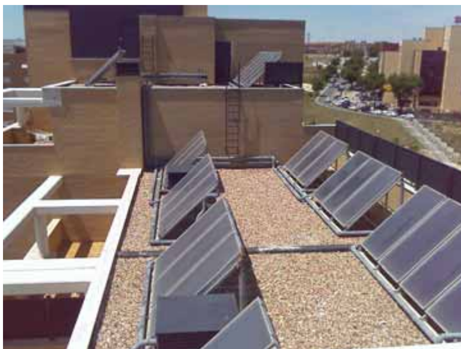
Foto A1.11. Grupo de paneles solares instalados en la cubierta de un edificio en Madrid (Fuente: Ferrolí).
