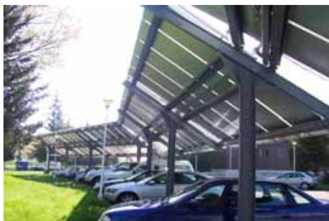
Foto A1.12. Ejemplos de paneles fotovoltaicos instalados en cubiertas de parking de restaurantes (Fuente: Ferroli).
