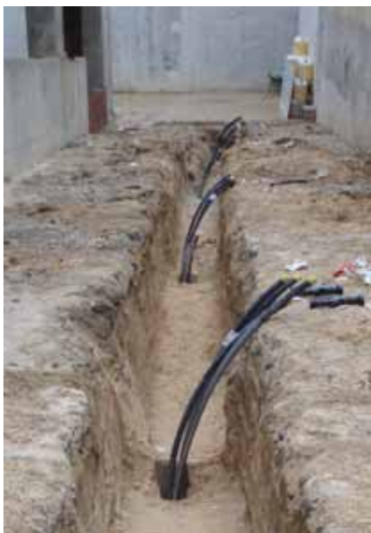
Foto A1.15. Ejemplo de campo de sondas geotérmicas (Fuente: Geoter).
