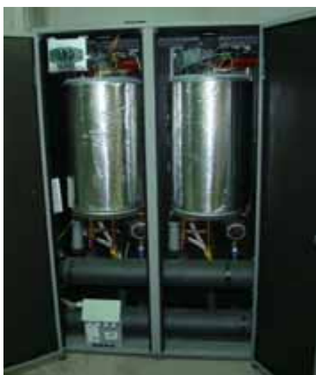
Foto A1.1. Calderas modulares de bajo NO x y condensación a gas natural. Vistas exterior e interior (Fuente: Ferroli).
