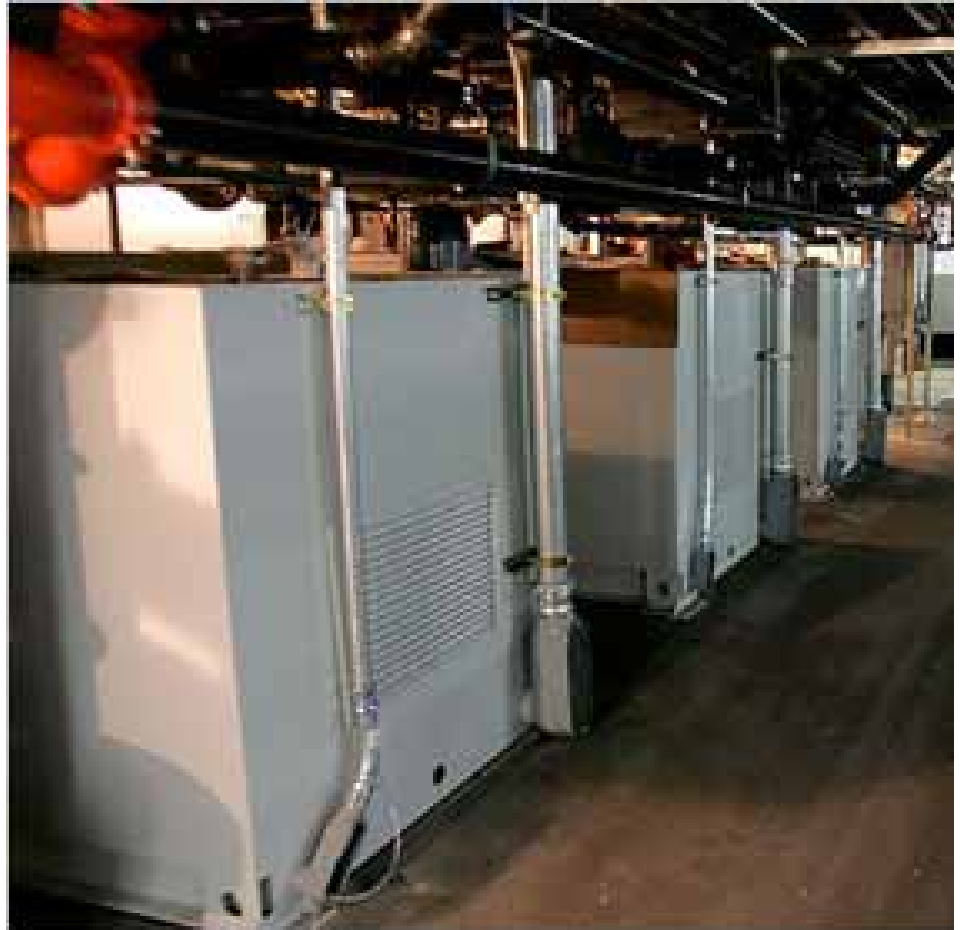
Foto A1.9. Grupos de cogeneración (Fuente: Earthfirst).
