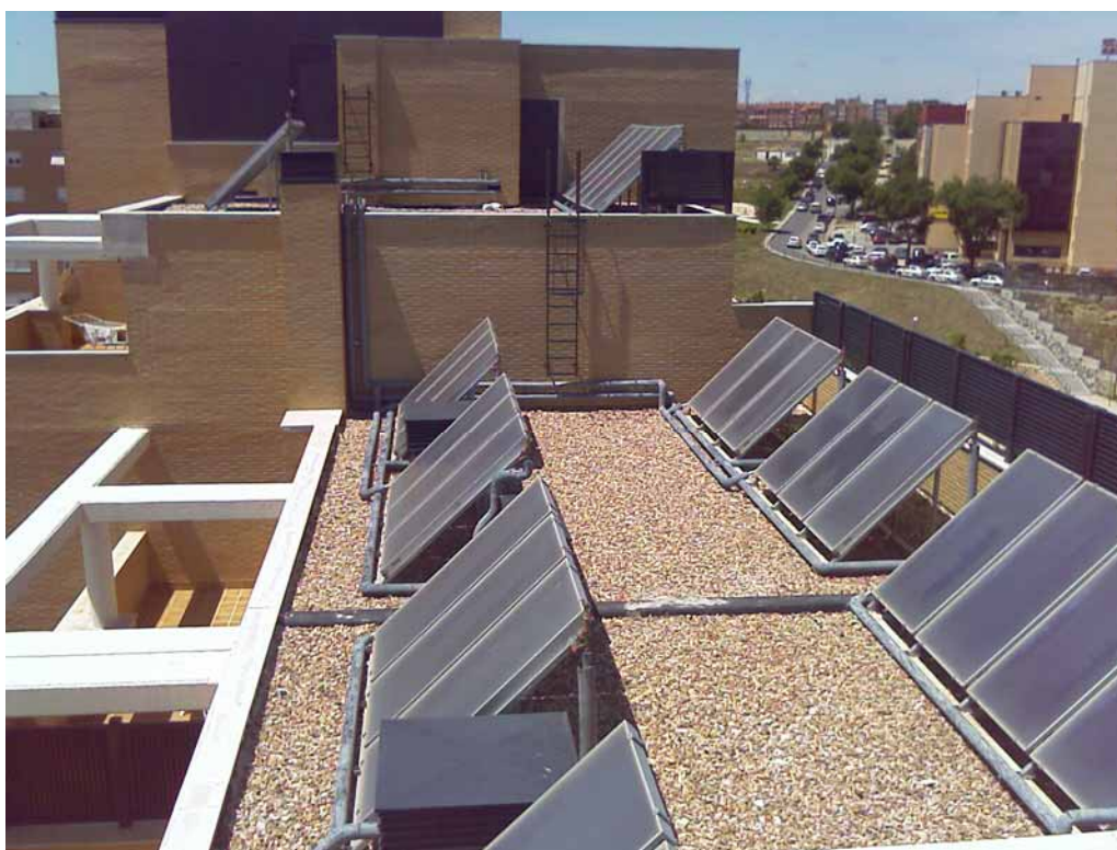
Foto A2.9. Instalación de captadores solares térmicos para producción de A.C.S. (Fuente: Ferroli).
