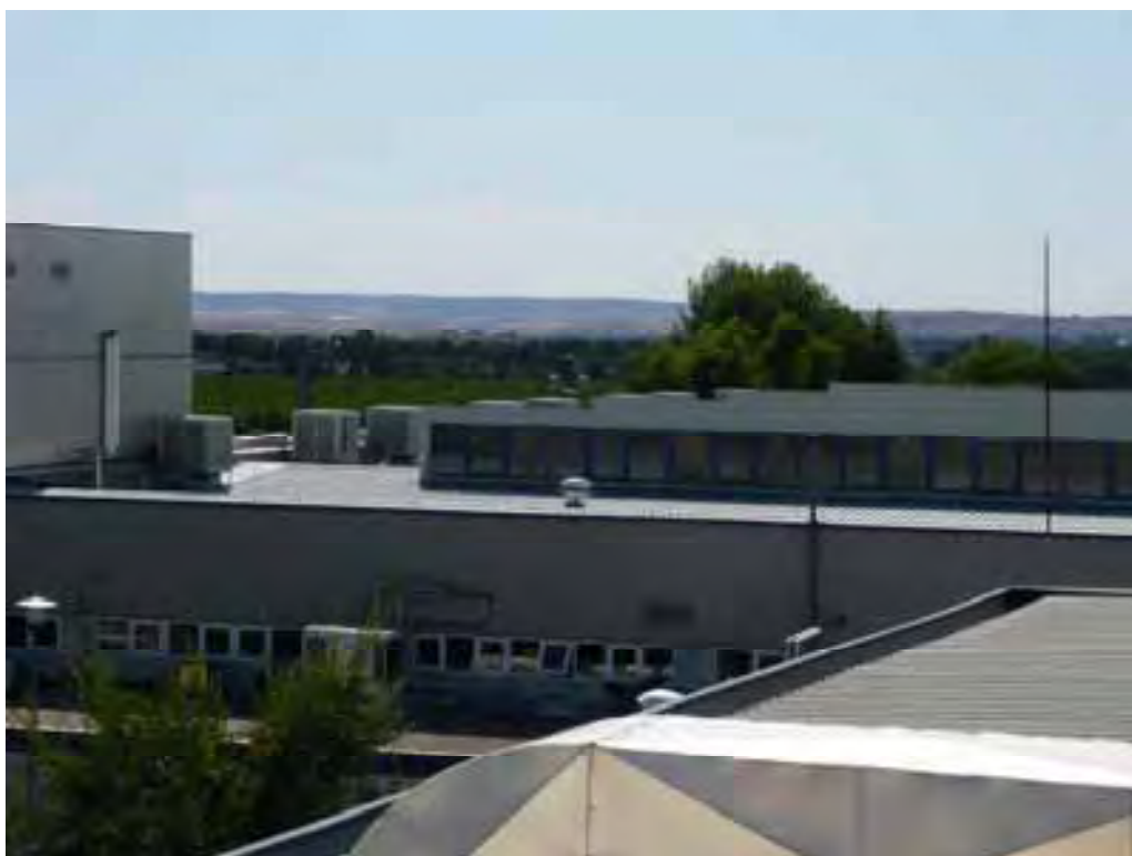
Foto 1.1. Cubierta de una instalación industrial.
