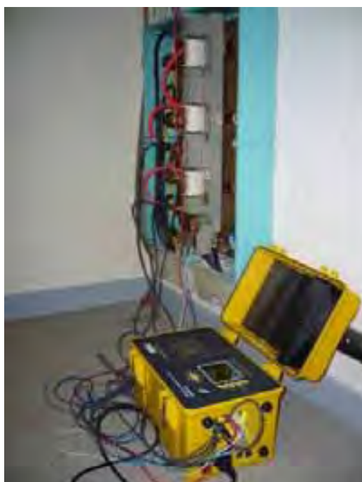
Foto 7.7. Conexión del analizador de redes en la acometida.
