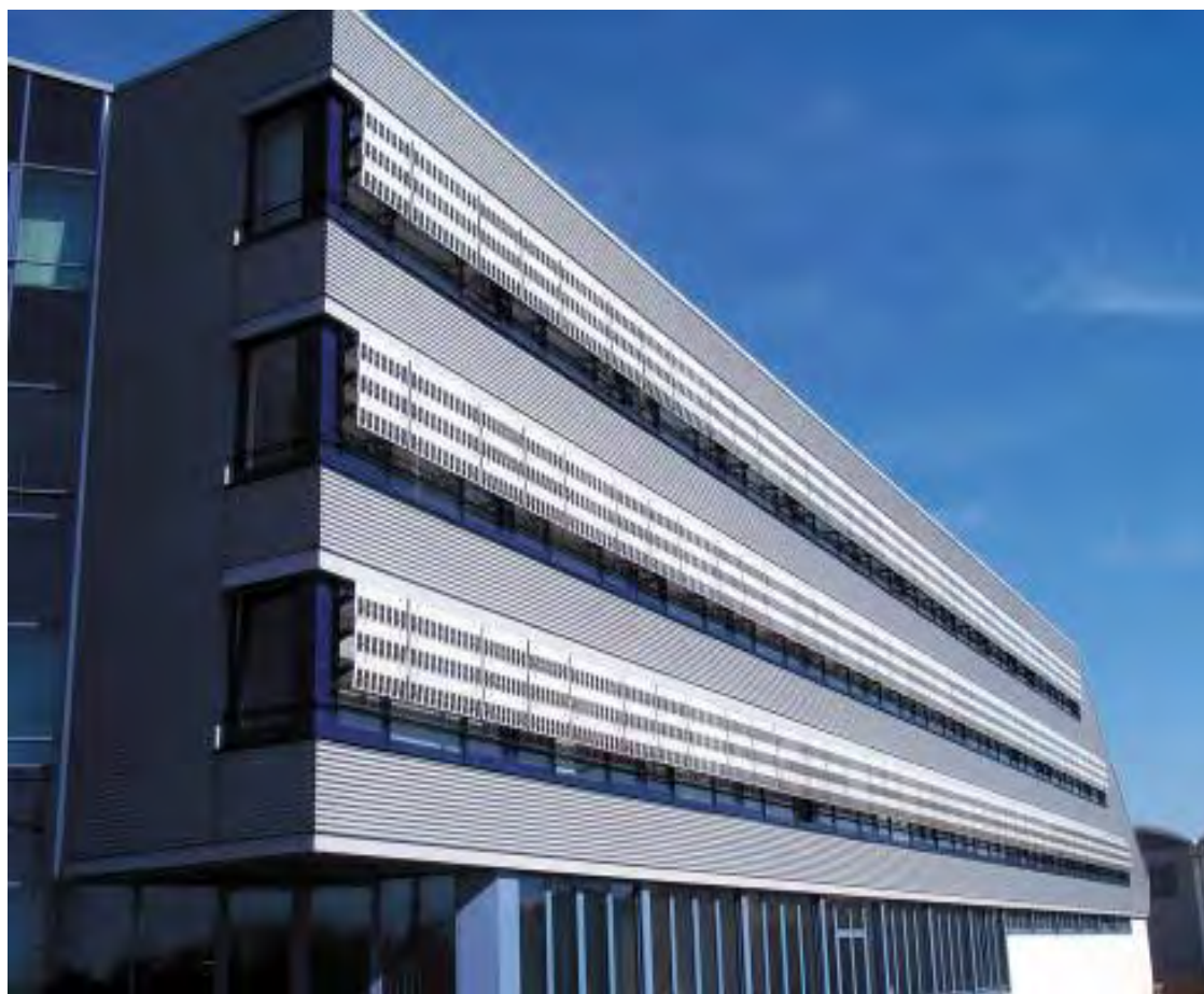
Foto 24. Instalación FV integrada en los parasoles en Eschweiler (Alemania).
