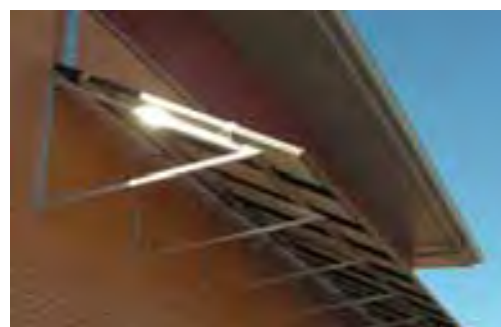
Foto 21. Instalación FV tipo Porche en urbanización MiraMadrid (Madrid) de 2,94 kWp.
