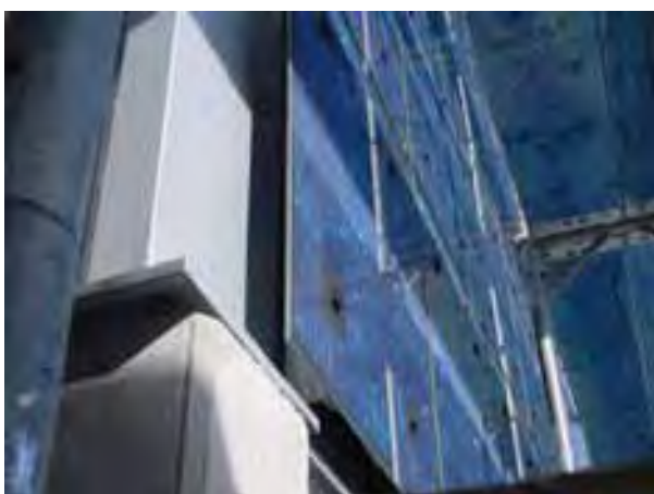
Foto 17. Detalles de los módulos y su sujeción.
