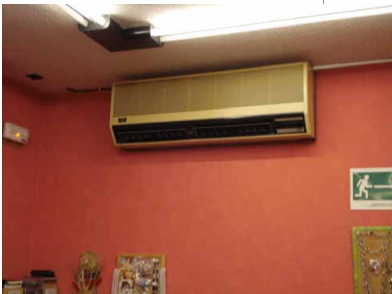
Foto 3.2. Bomba de calor tipo Split en una peluquería.
