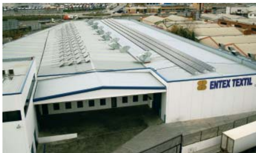
Instalación solar fotovoltaica de 108 kWp
