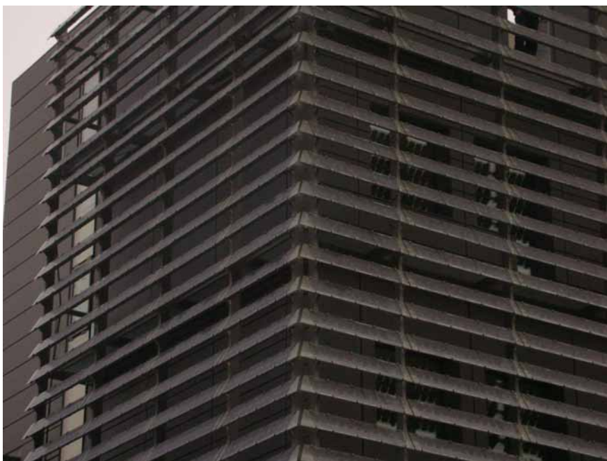
Foto 1. Lamas fotovoltaicas. Una forma de integración arquitectónica con generación de electricidad y protección solar del interior. Centro de Estudios del Alzheimer de la Fundación Reina Sofía.
