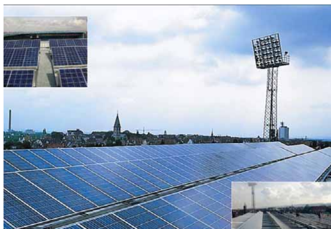
Foto 3. Módulos solares compuestos por células fotovoltaicas sobre estadio de fútbol.
