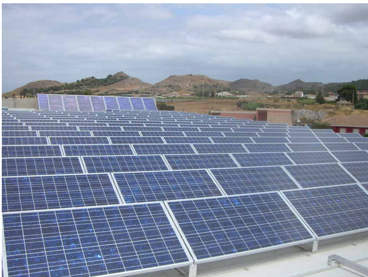
Foto 5. Cubierta de piscina municipal en La Unión (Murcia).
