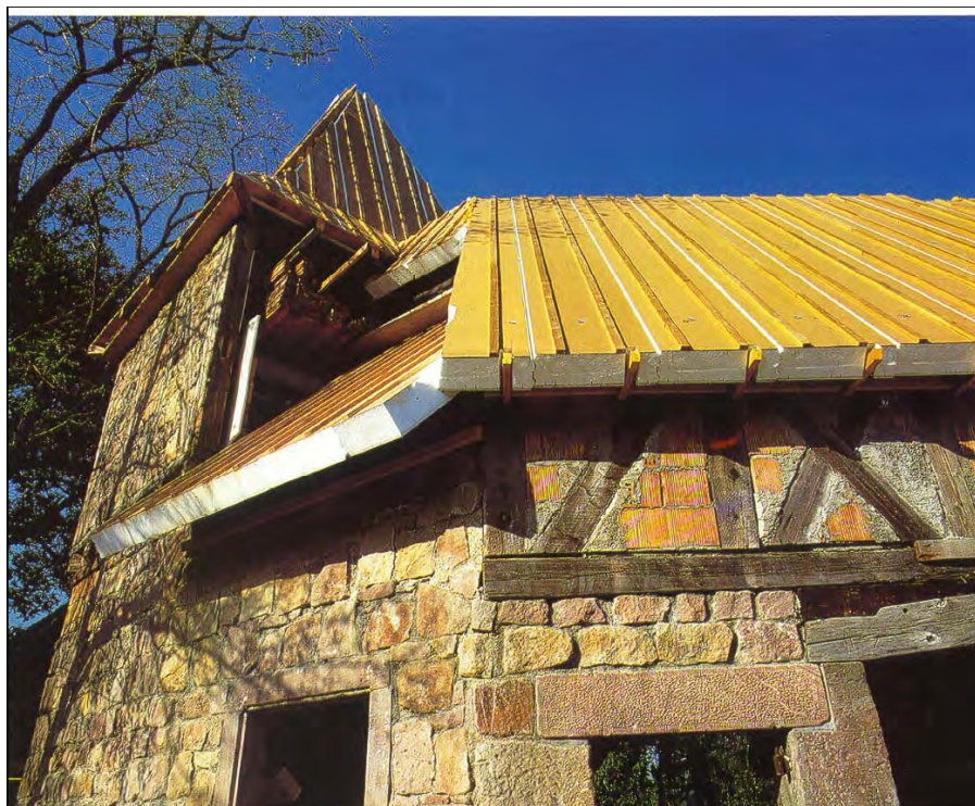
Foto 4. Lámina bajo cobertura.
