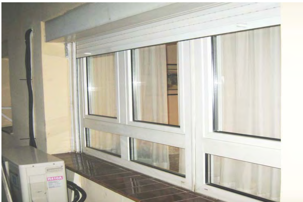
Foto 22. Carpintería PVC con doble acristalamiento bajo emisivo.
