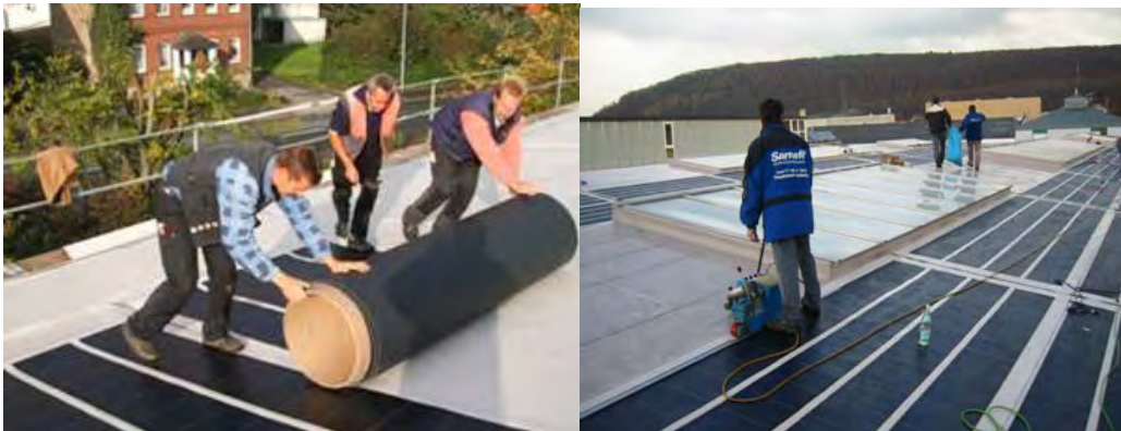
Figura 7. Montaje de los módulos-PV.
