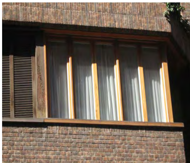
Foto 19. Carpintería de madera con doble acristalamiento banal.
