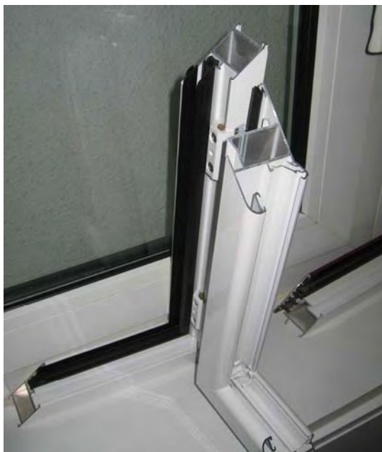
Foto 3. Carpintería metálica. Sección característica.
