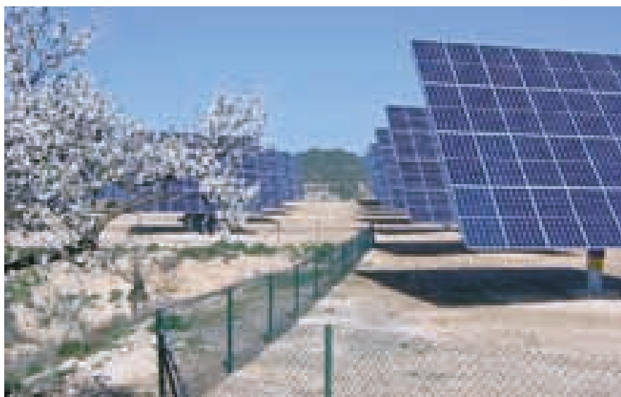
Foto 5. Agrupación de instalaciones fotovoltaicas.
