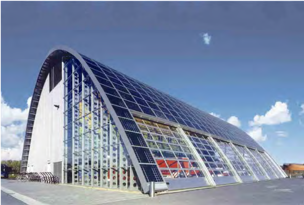
Foto 4. Integración fotovoltaica en lucernario o fachada.
