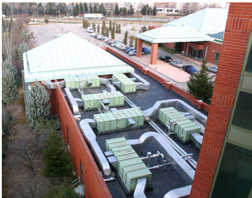
Foto 5. Condensador de un grupo de frío.
