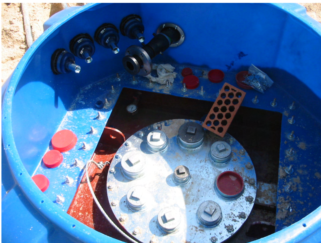
Foto 8. Recuperación de vapores.
