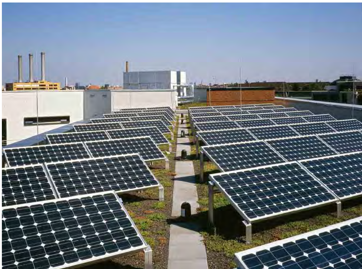
Foto 2. Módulos fotovoltaicos instalados sobre cubierta plana.
