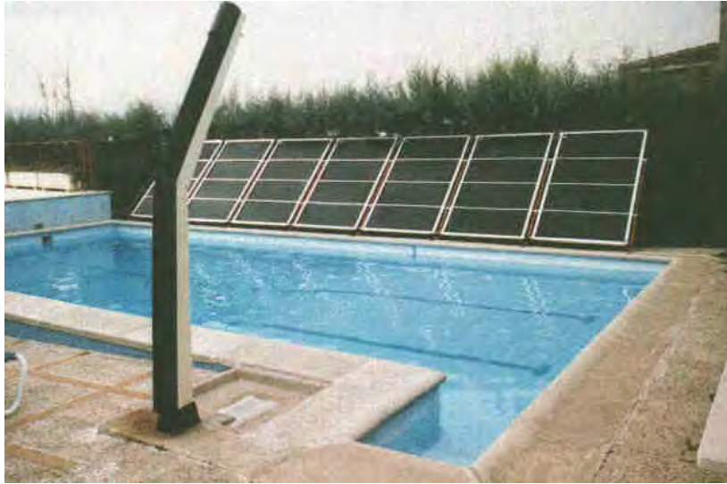
Foto 2. Colectores solares térmicos para piscina.
