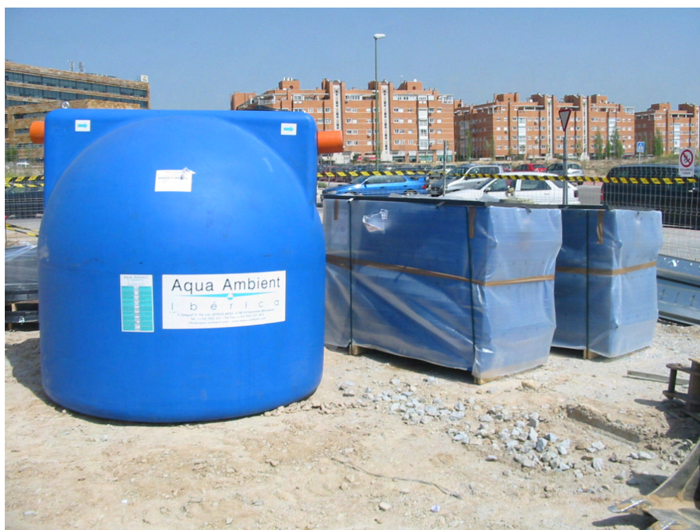
Foto 7. Separador de hidrocarburos.
