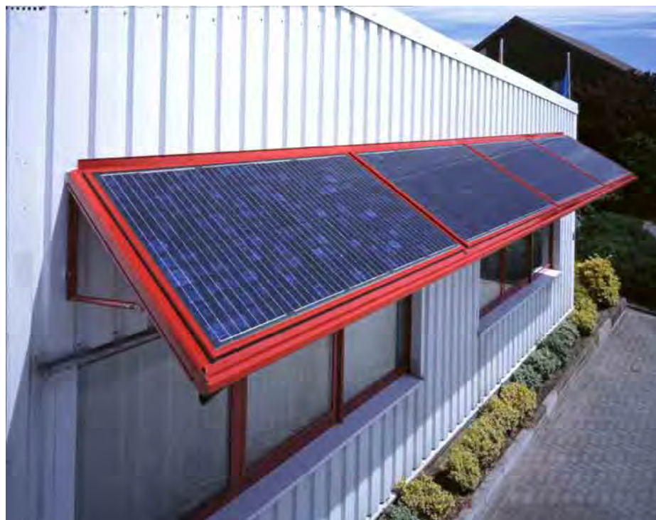
Foto 3. Instalación solar fotovoltaica en voladizo.
