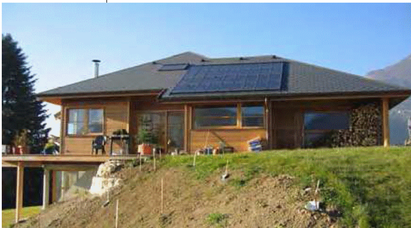
Foto 8.1. Vivienda unifamiliar con placas solares de apoyo a la instalación de aprovechamiento de calor geotérmico. (Fuente: Trillat-Berdal, V. et al. Synthèse du projet GEOSOL. Université de Savoie. France ).
