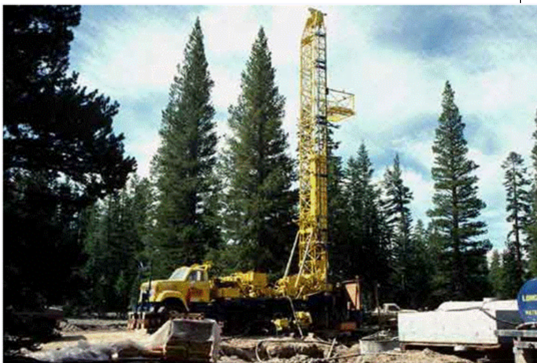
Foto 6.4. Una perforadora para pequeño diámetro, instalada sobre un camión y empleada en prospecciones, puede ser empleada para los pozos de producción y reinyección de una planta de pequeña potencia. (©2000 Geothermal Education Office).
