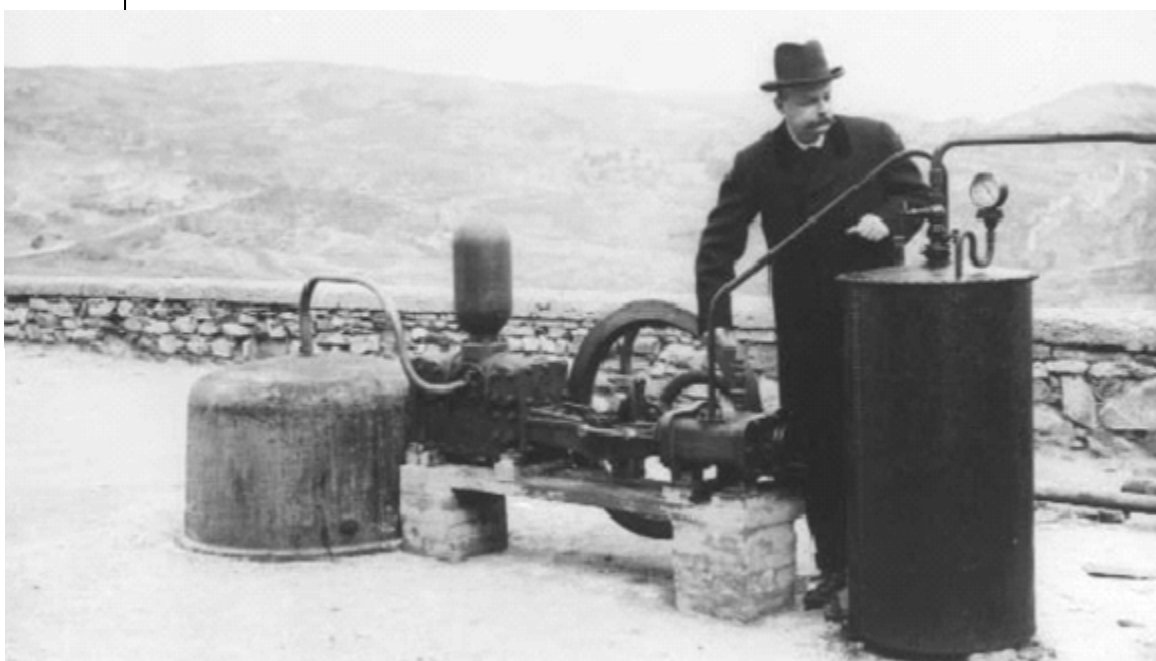
Foto 2.2. Primera instalación de generación de energía eléctrica de origen geotérmico en Larderello (Italia), en 1904. (© 2000 Geothermal Education Office).
