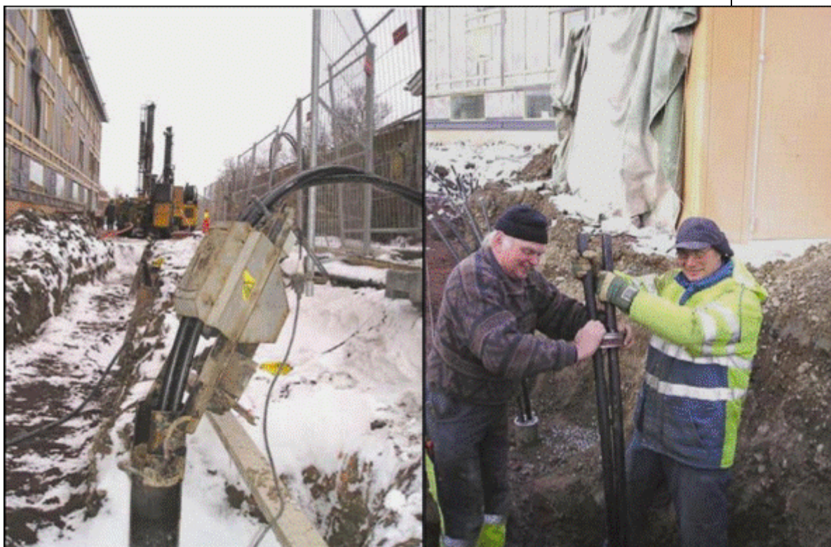
Foto 4.5. Salidas de tubos captadores desde sondas geotérmicas y montaje de una tapa. (Fuente: Solar Energy Efficiency Contactor).
