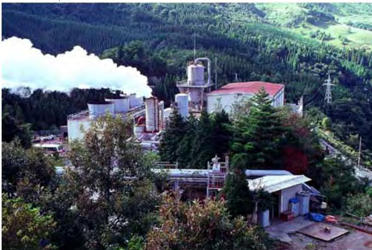
Foto 6.1. Planta de ciclo “flash” en Japón. El agua separada se reinyecta directamente al entorno del acuífero para no rebajar demasiado la temperatura del mismo. (©2000 Geothermal Education Office).
