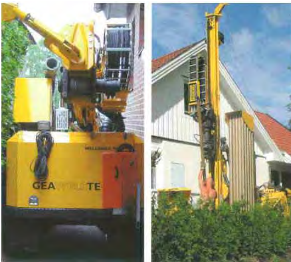
Foto 4.4. Perforación para sonda geotérmica al lado de una edificación. (Fuente: Girod Geotermia ).
