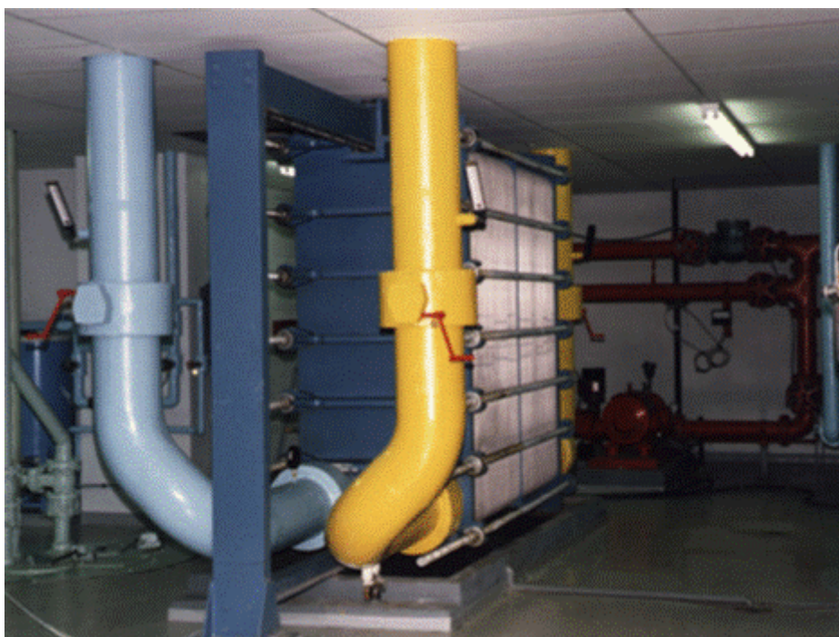
Foto 5.2. Intercambiador de calor de placas. (Fuente: @2000 Geothermal Education Office).
