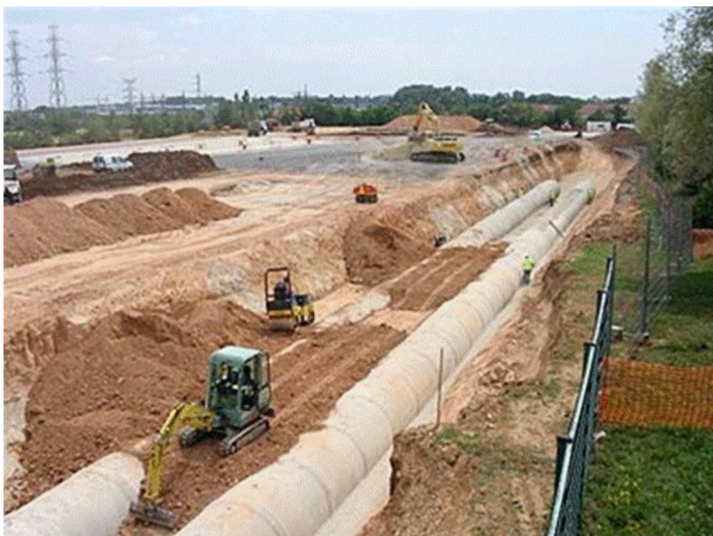
Foto 4.10. Conducciones de 700 m de longitud utilizadas como pozo canadiense en Dijon. Francia. (Fuente: Site Geothermie-Perspectives de l'ADEME et du BRGM).
