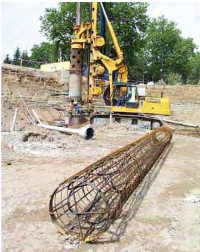
Foto 4.7. Armadura de pilote con captadores antes y después de su colocación. (Fuente: www.enercret.com ).
