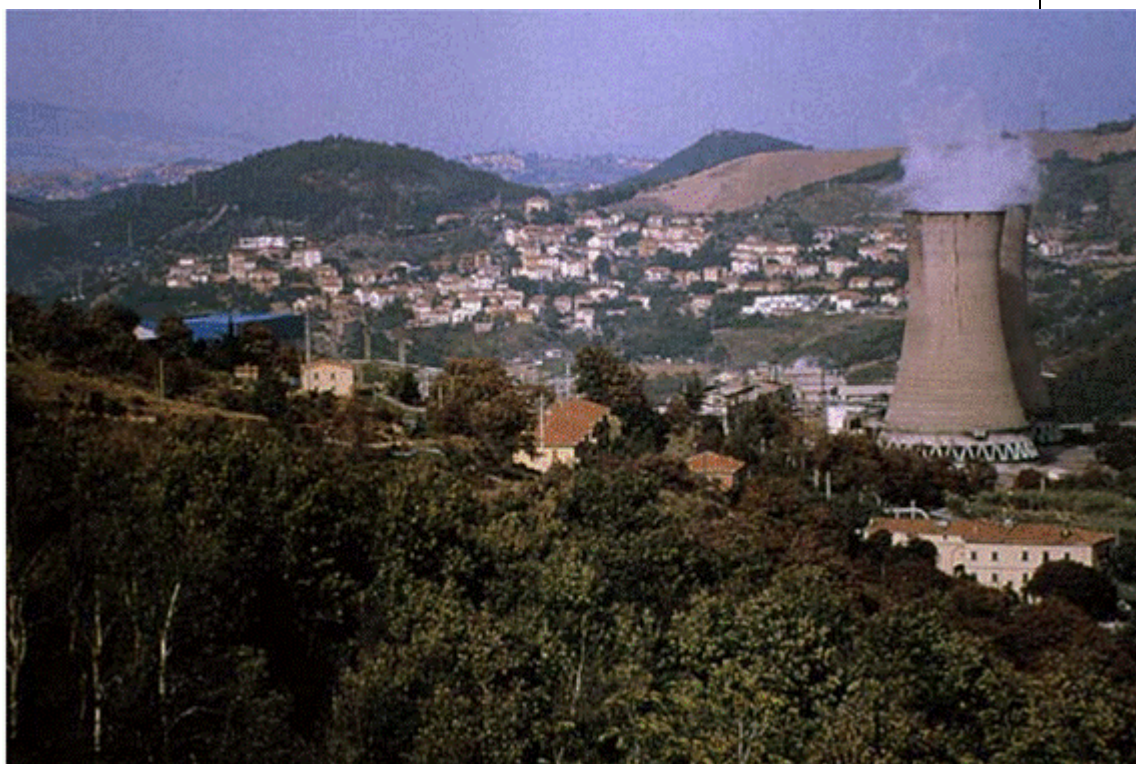
Foto 2.3. Después de 100 años el Campo geotérmico de Larderello continúa productivo. (©2000 Geothermal Education Office).
