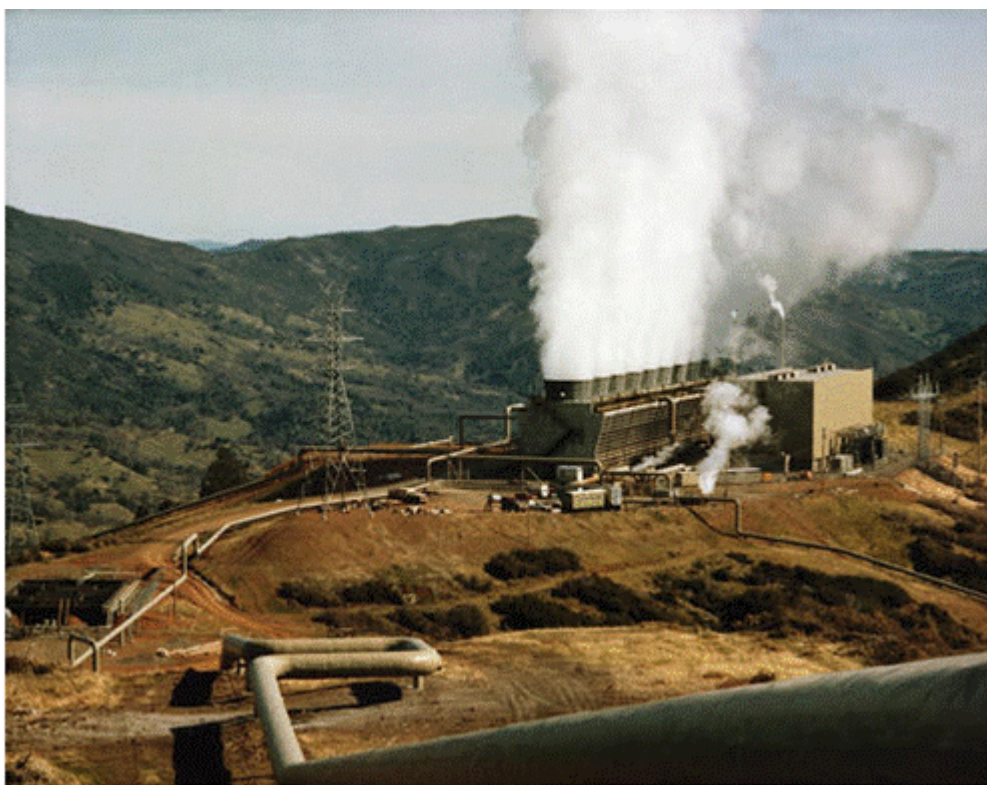
Foto 2.4. Emisiones de vapor en una central de vapor seco en The Geysers, California (EE. UU.) (Fuente: Pacific Gas and Electric ).
