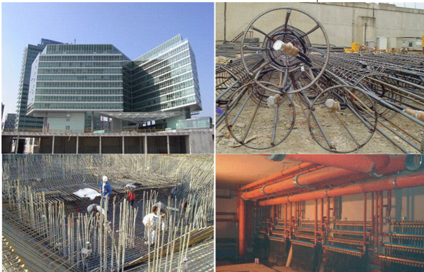
Foto 4.8. Edificio Strabag Headquarters en Viena (Austria). Fases de construcción y aspecto final. (Fuente: www.enercret.com ).
