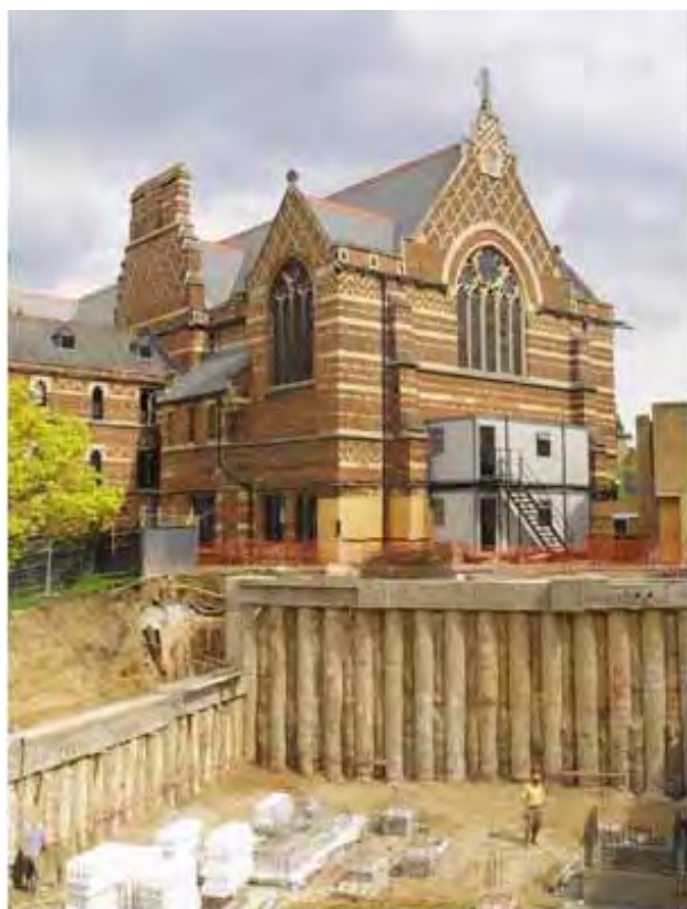
Foto 3.4. Muros de contención con 90 pilotes geotérmicos en Keble College, Oxford (R.U.). Potencia de calefacción 45 kW. Terminado en 2001. (Fuente: www.enercret.com ).
