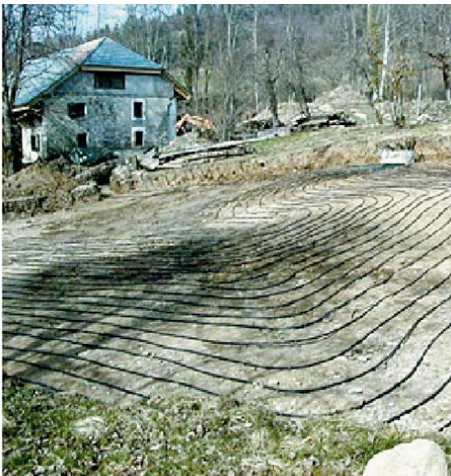
Foto 3.3. Red de captadores horizontales de polietileno antes de ser enterrada. (Fuente: Site Geothermie-Perspectives de l'ADEME et du BRGM ).
