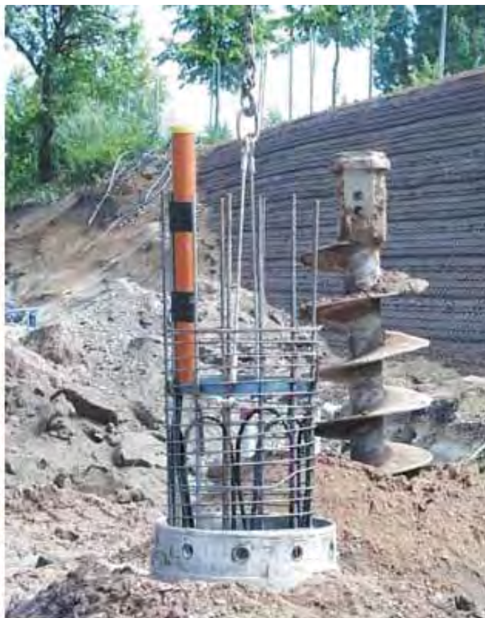
Foto 4.7. Armadura de pilote con captadores antes y después de su colocación. (Fuente: www.enercret.com ).
