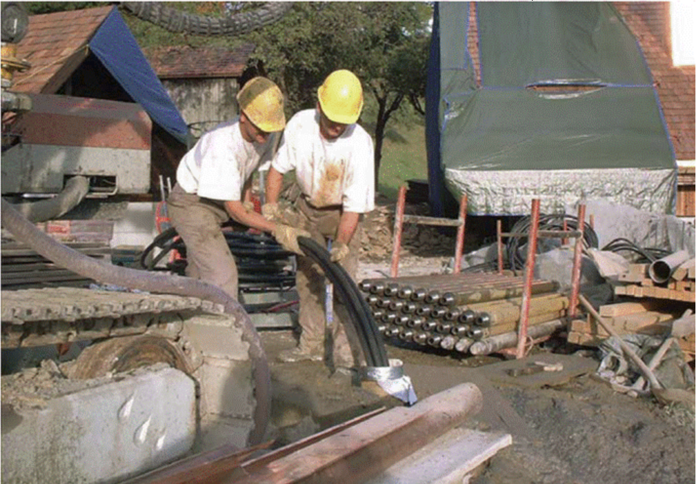
Foto 8.2. Introducción de los intercambiadores en una perforación. (Fuente: La Géothermie. ADEME - BRGM ).
