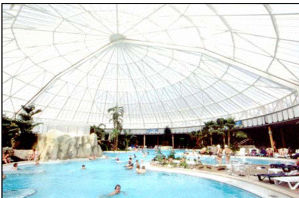
Foto 5.3. Piscina climatizada en Erding, cerca de Munich, al pie de los Alpes. (Fuente: www.geothermie de 2007 ).
