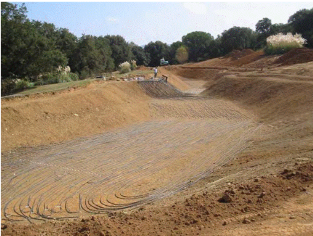
Foto 4.2. Excavación de grandes dimensiones y extendido de tubos captadores. (Fuente: Aplicacions Geotèrmiques. Geòtics Innova. Seminario Energía, Edificación y Cambio Climático. Barcelona 2005 ).
