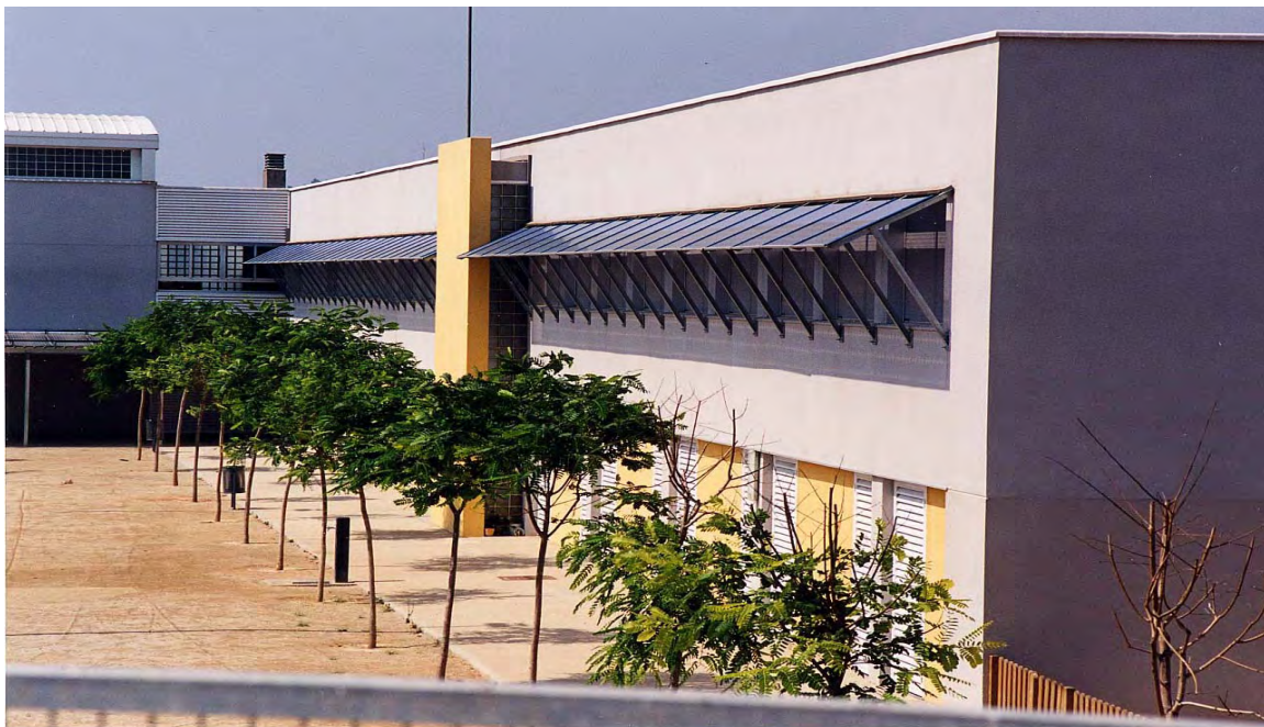
Foto 11. Instalación fotovoltaica integrada en parasoles.
