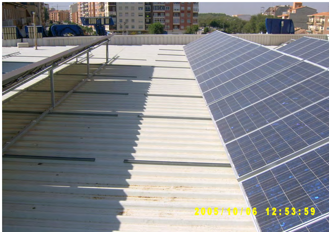
Foto 5. Estructura sobre tejado plano de uralita.
