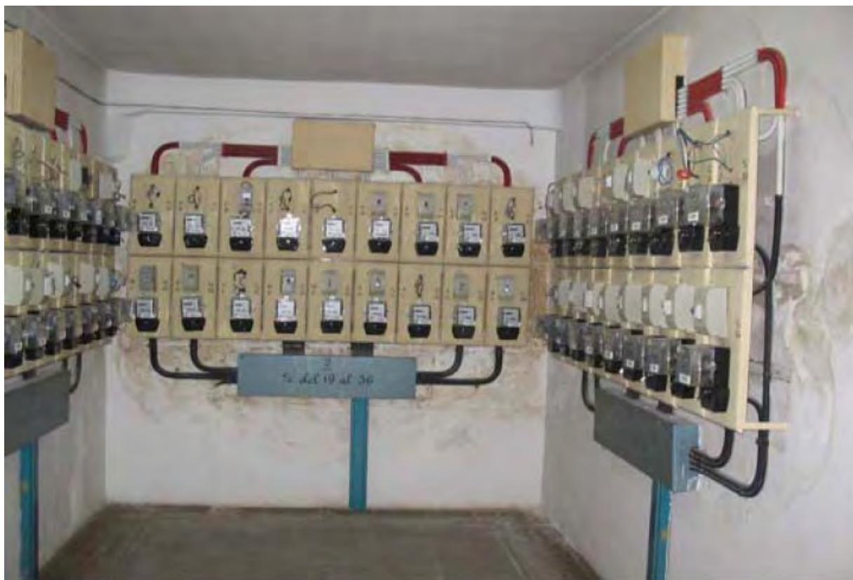
**Figura 5.** Centralización de contadores.
