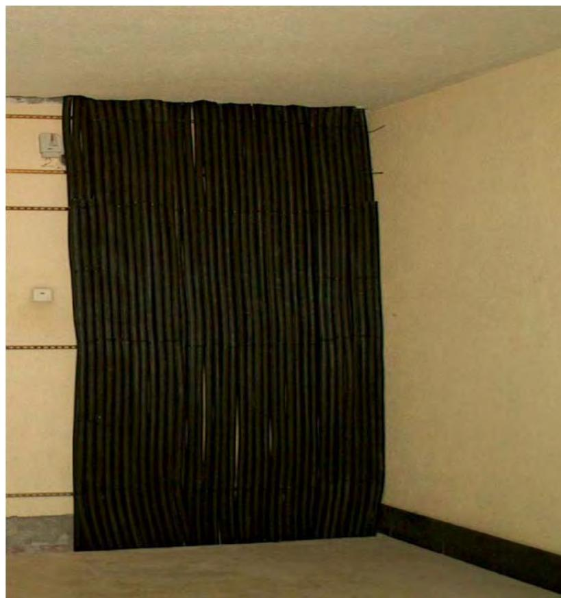
Figura 8. Canalizaciones de derivaciones individuales.
