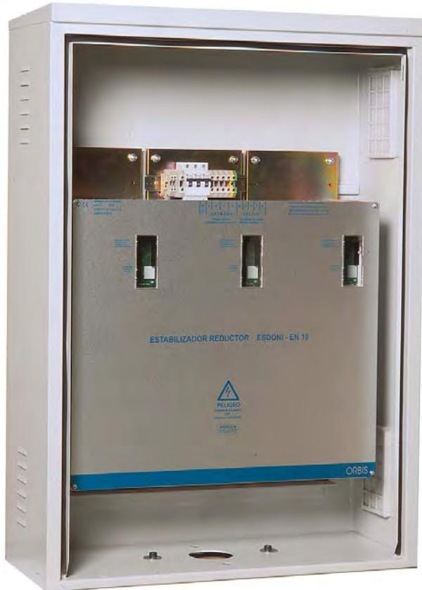
**Foto 8.** Ejemplo de estabilizador-reductor de flujo.
