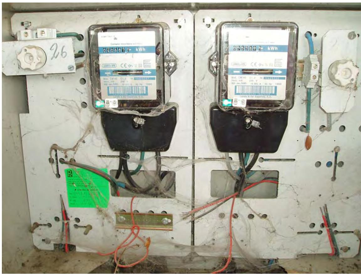
Figura 7. Detalle de contadores de inducción.
