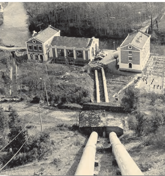
Central de Anguiano, en La Rioja, de Iberdrola. Data de 1921, y tiene 3 grupos de 1,16 MW cada uno.
