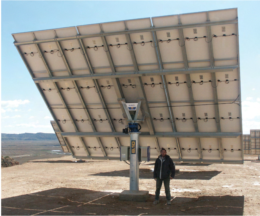
Foto 7. Instalación fotovoltaica sobre seguidor solar.
