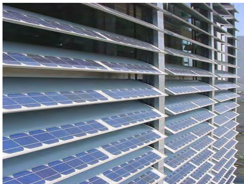
Foto 10. Instalación fotovoltaica integrada en lamas.
