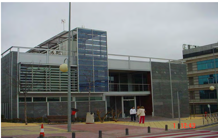
Foto 8. Instalación fotovoltaica integrada en muro cortina.
