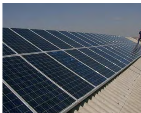
Foto 4. Estructura sobre tejado inclinado de uralita.
