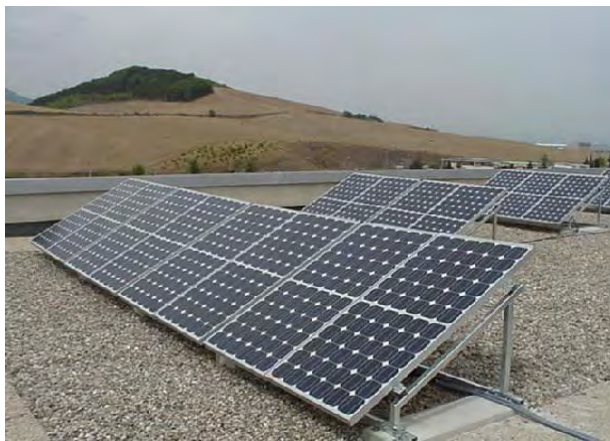
Foto 6. Sistema fotovoltaico sobre tejado plano no perforable.
