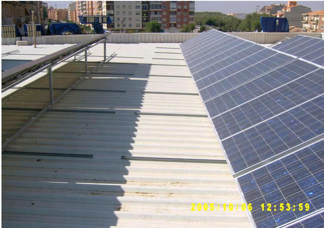
Foto 5. Estructura sobre tejado plano de uralita.
