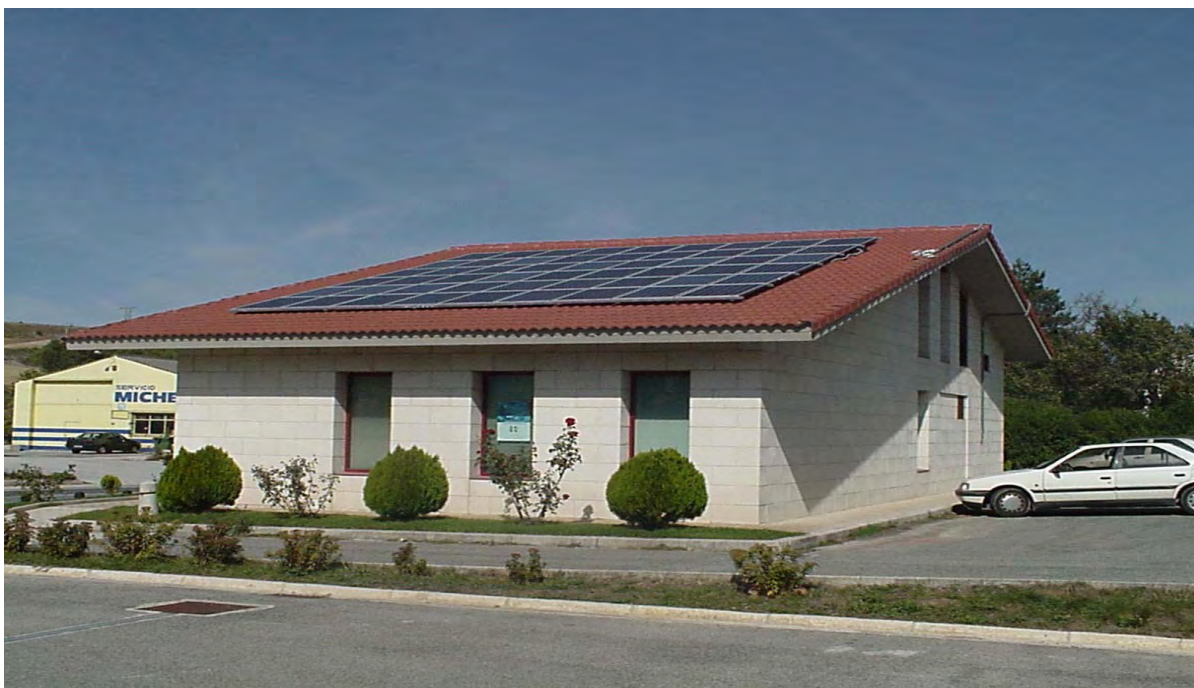
Foto 3. Sistema fotovoltaico sobre tejado inclinado.
