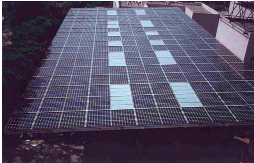
Foto 9. Instalación fotovoltaica integrada en cubierta.
