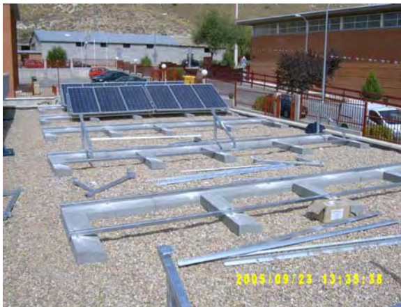
Foto 6. Sistema fotovoltaico sobre tejado plano no perforable.
