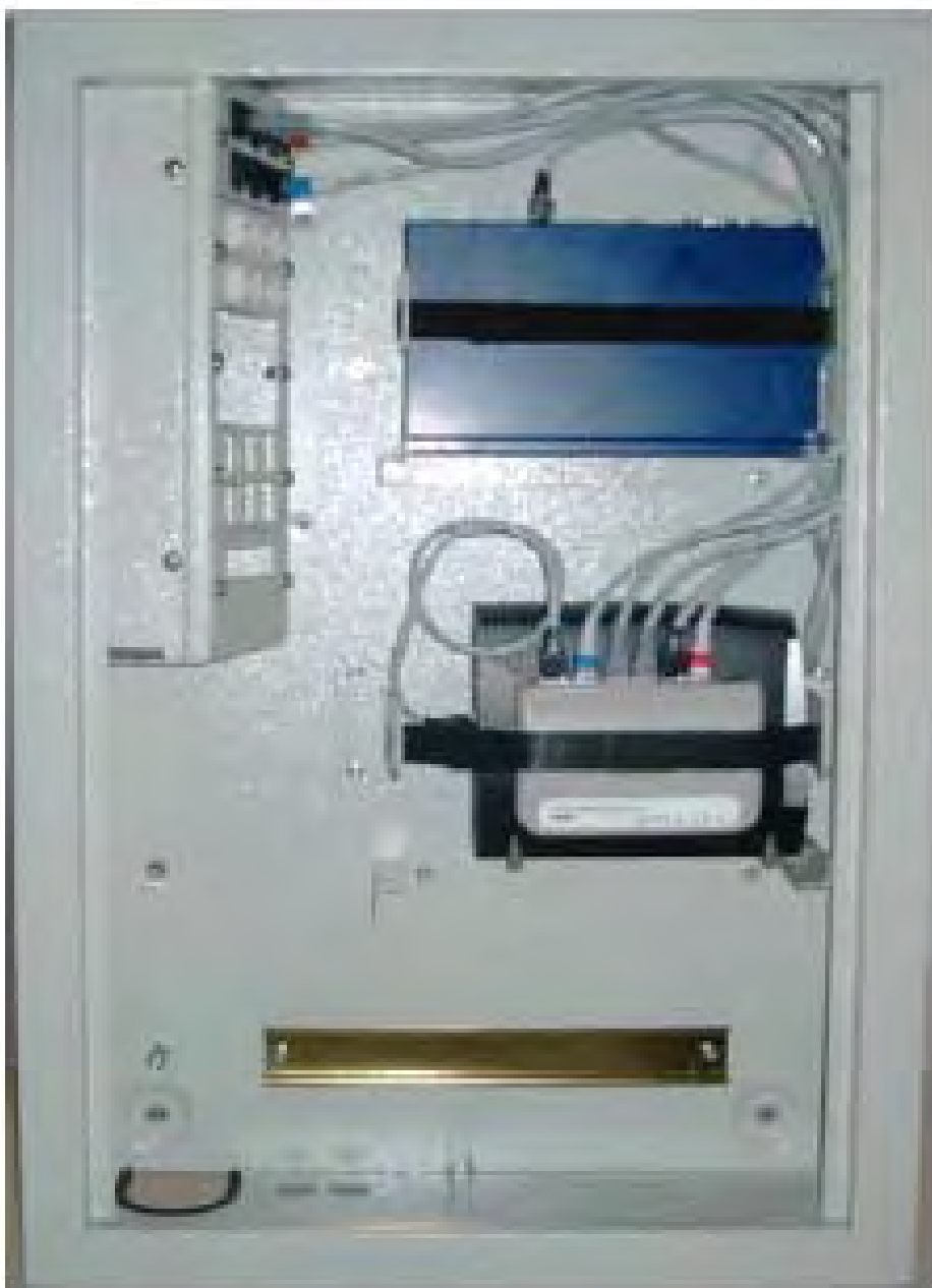
Figura 5. RTR sobredimensionado para albergar más servicios que los mínimos de ICT (Cortesía de Dave Witter).
