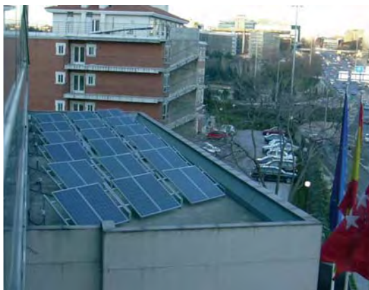
Módulos fotovoltaicos instalados en la cubierta.
