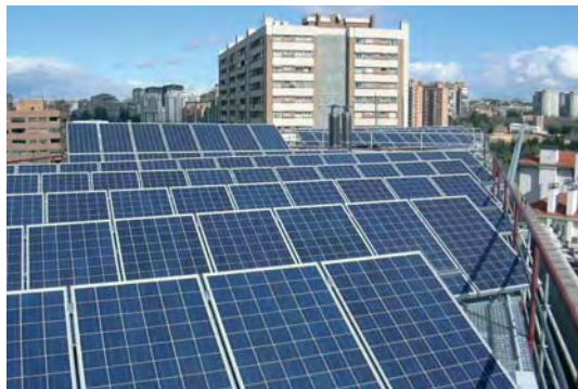
Módulos fotovoltaicos instalados en la cubierta.
