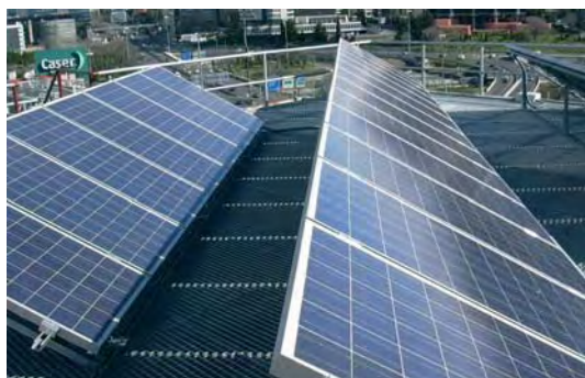
Módulos fotovoltaicos instalados en la cubierta.
