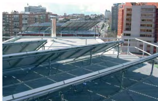
Módulos fotovoltaicos anclados sobre tramex en la cubierta.
