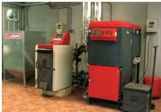
Calderas automáticas de biomasa para calefacción de las dependencias y el invernadero de investigación del Grupo de Agroenergética de la ETSIA.
