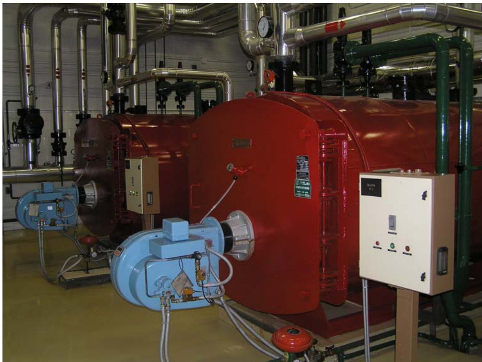
Foto 3. Instalación de caldera en edificio.
