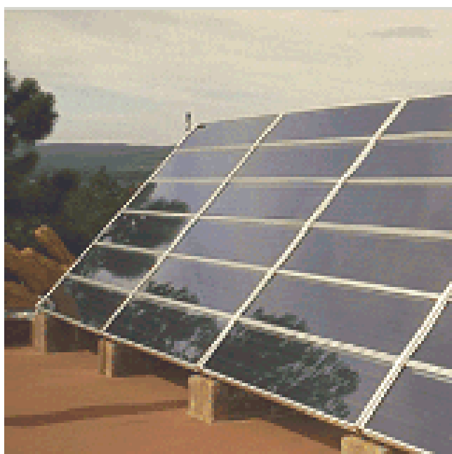
Foto 4. Instalación energía Térmica.
