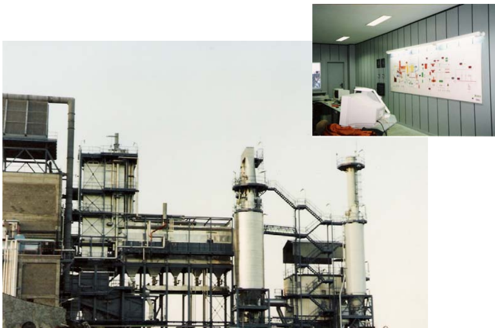
Foto 1. Planta de Incineración y su sala de control (Fuente: L. Mtz. Centeno – Planta de Melilla).
