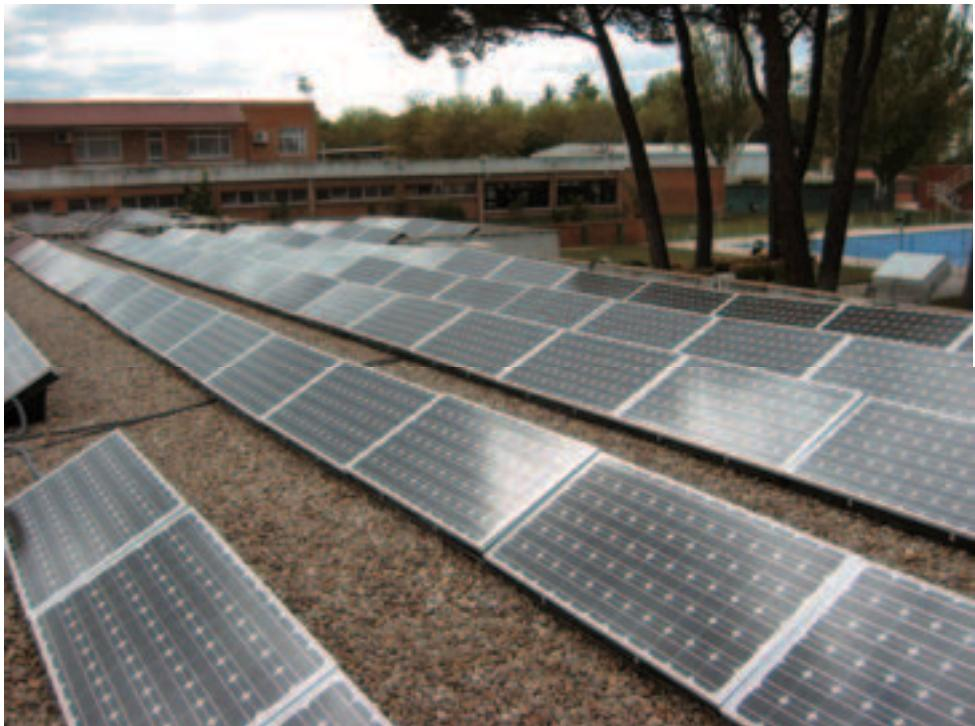
**Foto 5.** Instalación de conexión a red en la cubierta de un edificio.
