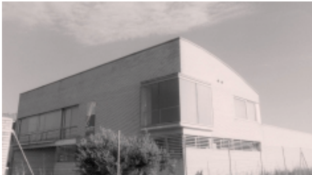
Fábrica de Enertrón en Torres de la Alameda
