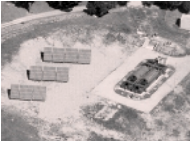
Planta de tratamiento de aguas del Canal de Isabel II en la Sierra Noroeste de Madrid
