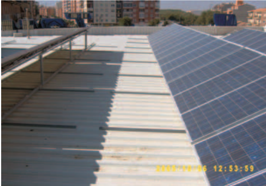
Foto 5. Estructura sobre tejado plano de uralita.
