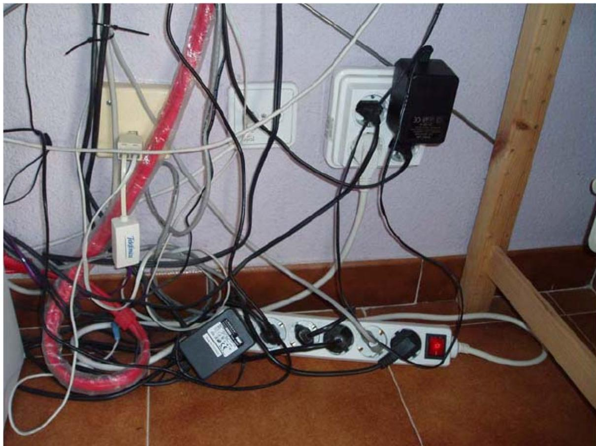
**Figura 16.** Incorrectas conexiones en enchufes múltiples.
