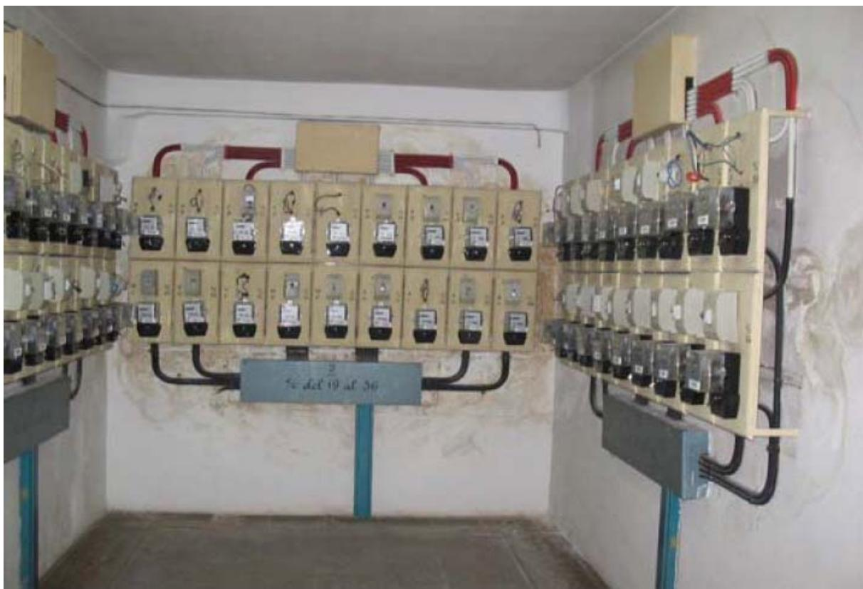
**Figura 5.** Centralización de contadores.
