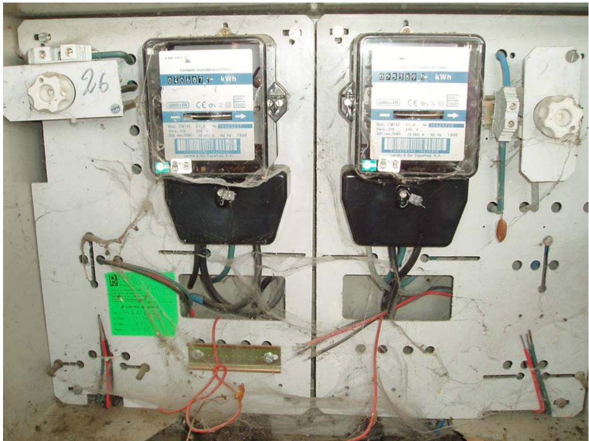
Figura 7. Detalle de contadores de inducción.
