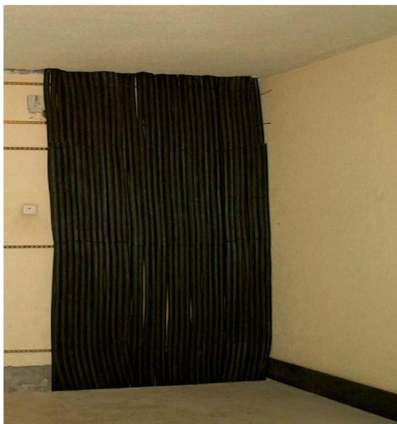
Figura 8. Canalizaciones de derivaciones individuales.
