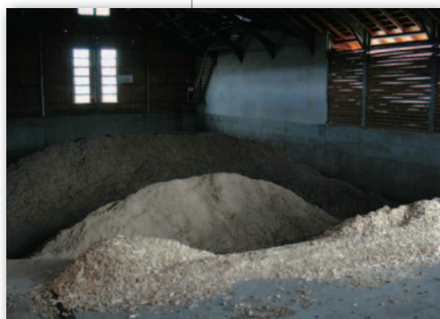
Figura 5: Nave para almacenamiento de astillas.
