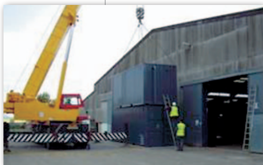
Figura 24: Caldera y almacén de pellets en contenedores.
