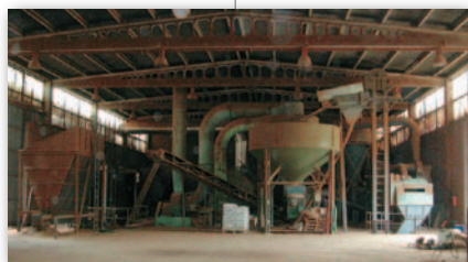
Figura 17: Planta de pelletización (La Coruña)
