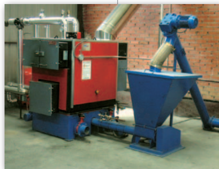
Figura 32: Caldera de pellets (admite otros combustibles) de 250 kW de potencia.
