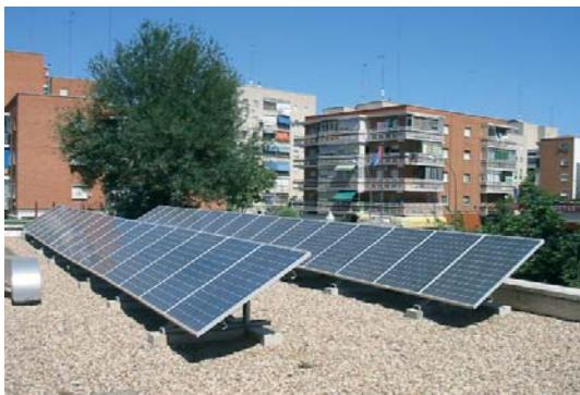
En ambos edificios, la orientación de los paneles fotovoltaicos es 20° SO que, aunque no maximiza la radiación solar incidente, sí permite una mejor integración de la instalación en el edificio.
