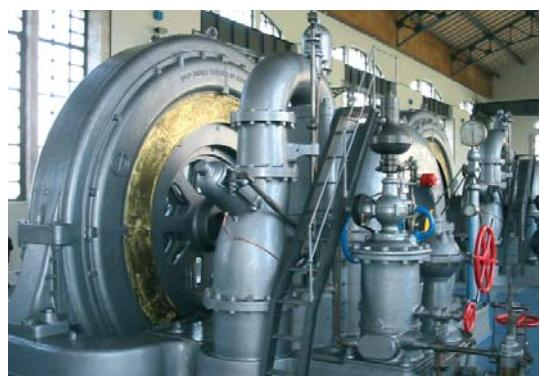
El monitoreo y control de las centrales se realiza por circuito remoto; existe un autómata in situ en cada turbina; éste manda los datos a una sala de control dentro de la Central; por fibra óptica se puede recibir en el
