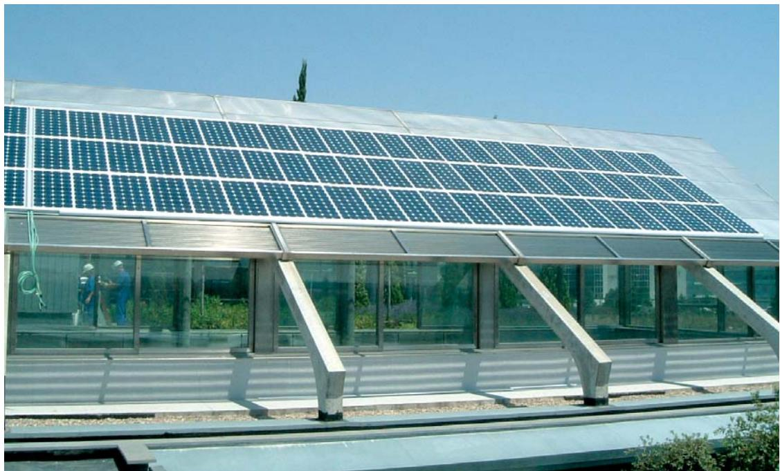
La instalación solar, con una superficie útil de captación de 170 m<sup>2</sup>, tiene una potencia total de 30,6 kWp y una capacidad de producción de aproximadamente 44.000 kWh/año.
