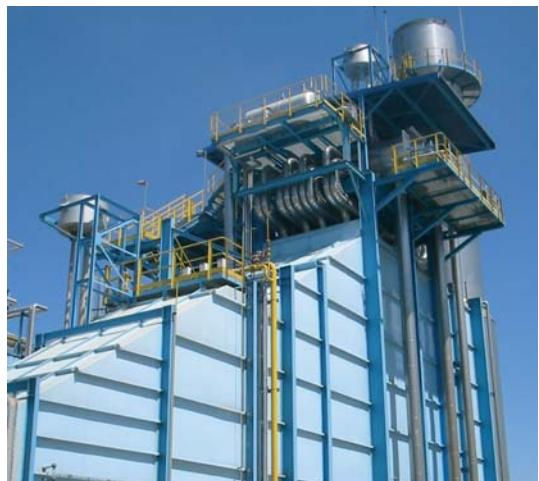
A comienzos del año 2007, una nueva planta de cogeneración abastecerá las necesidades energéticas de la nueva línea de fabricación de HPM con 35 MW eléctricos y 67 t/h de vapor con una potencia instalada entorno a 40-50 MW, equivalentes al consumo doméstico de 200.000-250.000 hogares, vertiendo a la red 10-15 MW. Los ahorros de energía primaria previstos son mayores al 16 %.
