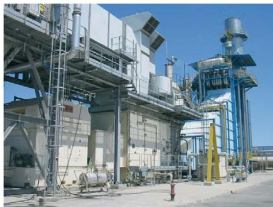
Además, esta producción se hace asegurando el máximo aprovechamiento eléctrico y térmico, puesto que se ha seleccionado la turbina de mayor rendimiento dentro de su gama de potencias, se han elegido las mejores condiciones posibles para el ciclo de vapor, se produce agua caliente con calor de cola de caldera para sustituir consumos de vapor de la fábrica y se ha producido frío con el calor excedente.
