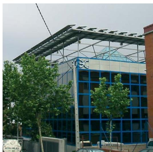
Los paneles fotovoltaicos, con 15º de inclinación y orientados al sur, están situados en la pérgola del edificio y la estructura de soporte es de acero galvanizado.
