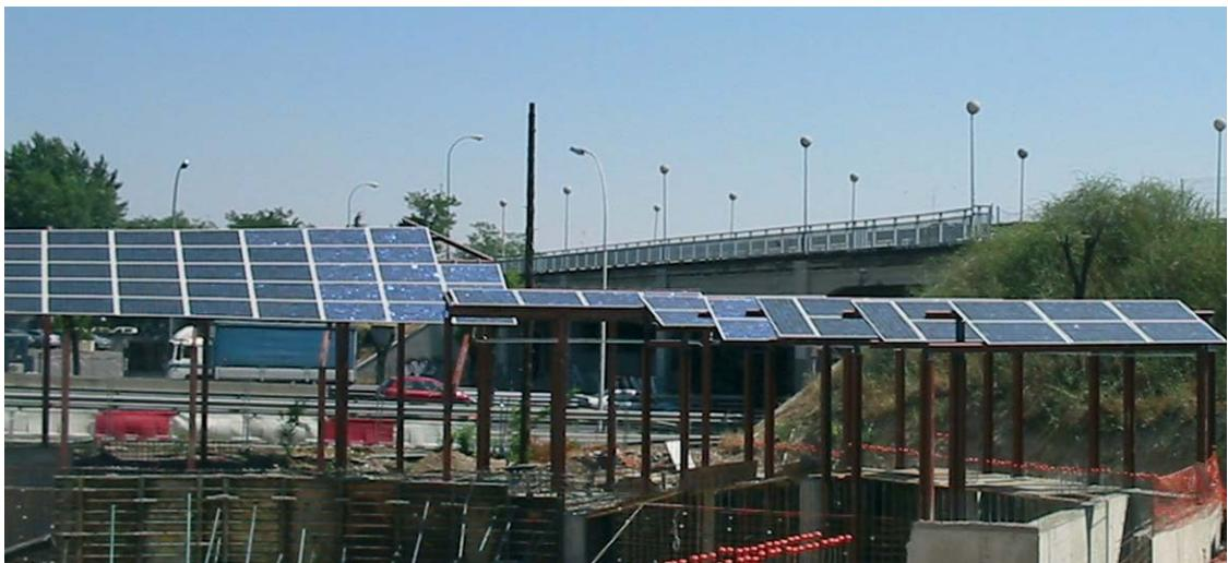
La climatización de la piscina se realiza a través de 6 colectores con una superficie total de captación de 12 m<sup>2</sup>. Estos colectores están situados en la misma pérgola en la que se encuentran los módulos fotovoltaicos.
