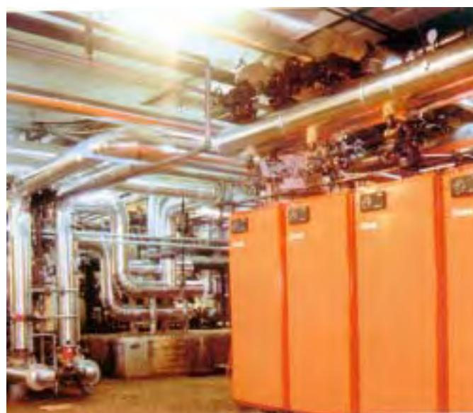
**Figura 11.** Calderas para agua caliente.
