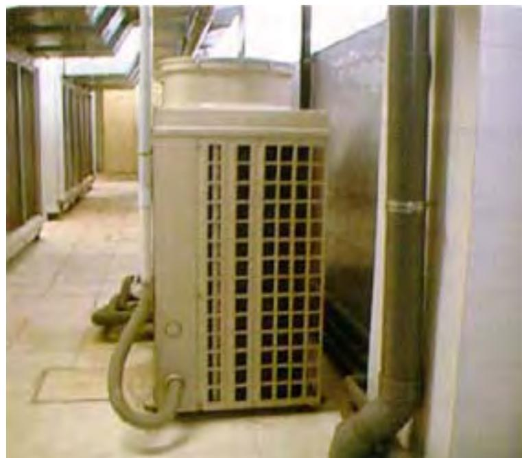
**Figura 10.** Condensador de un grupo de frío.
