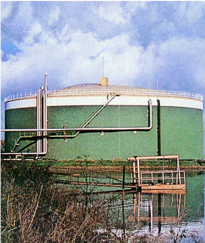
Planta de digestión anaerobia de aguas residuales.
