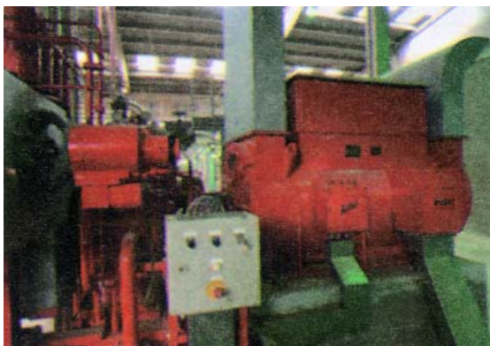
Instalación de una turbina de vapor.
