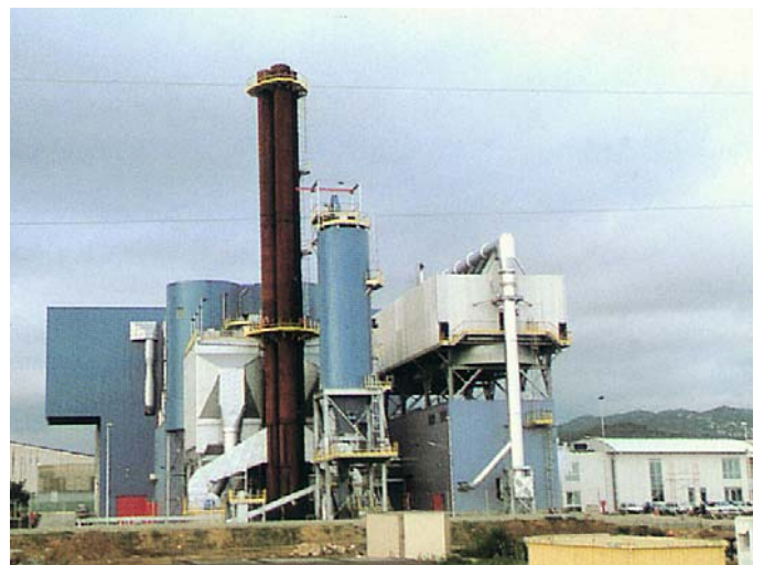
Centro de valoración energética de los residuos, con depuración y control de las emisiones de humos.
