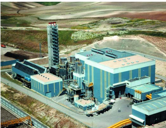
Planta incineradora de TirMadrid.
